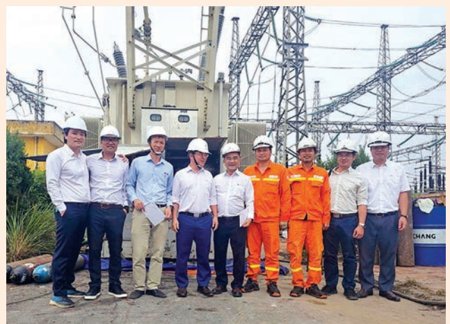
Ông Phạm Quang Hòa (thứ 4 từ trái qua) tặng quà động viên CBCNV trực tiếp thi công tại công trường
