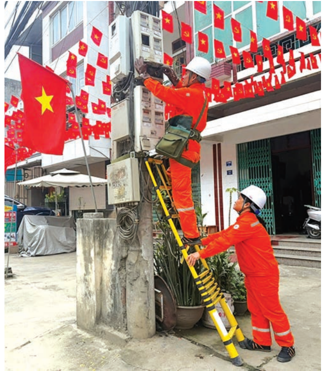
Nhân viên Đội QLĐLKV Bằng Giang - Công ty Điện lực Cao Bằng kiểm tra định kỳ, xử lý khiếm khuyết đảm bảo cấp điện phục vụ bầu cử
