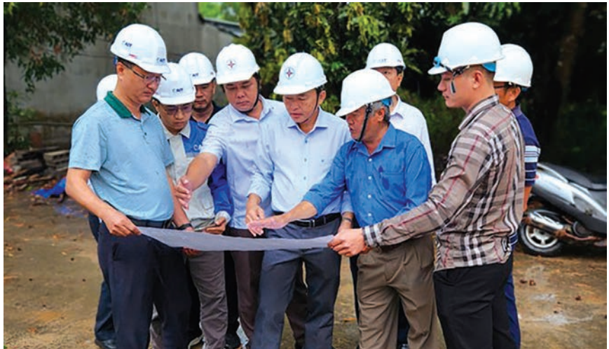
Phó Tổng Giám đốc Đào Hòa Bình (hàng trên thứ 3 bên phải qua), kiểm tra hiện trường công trình ĐTXD điện trên địa bàn Đặc khu Phú Quốc - An Giang
