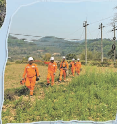
Công nhân PC CAO BẰNG khắc phục nhanh sự cố đường điện Bản Khau xã Thống Nhất (Hà Lạng - Cao Bằng).
