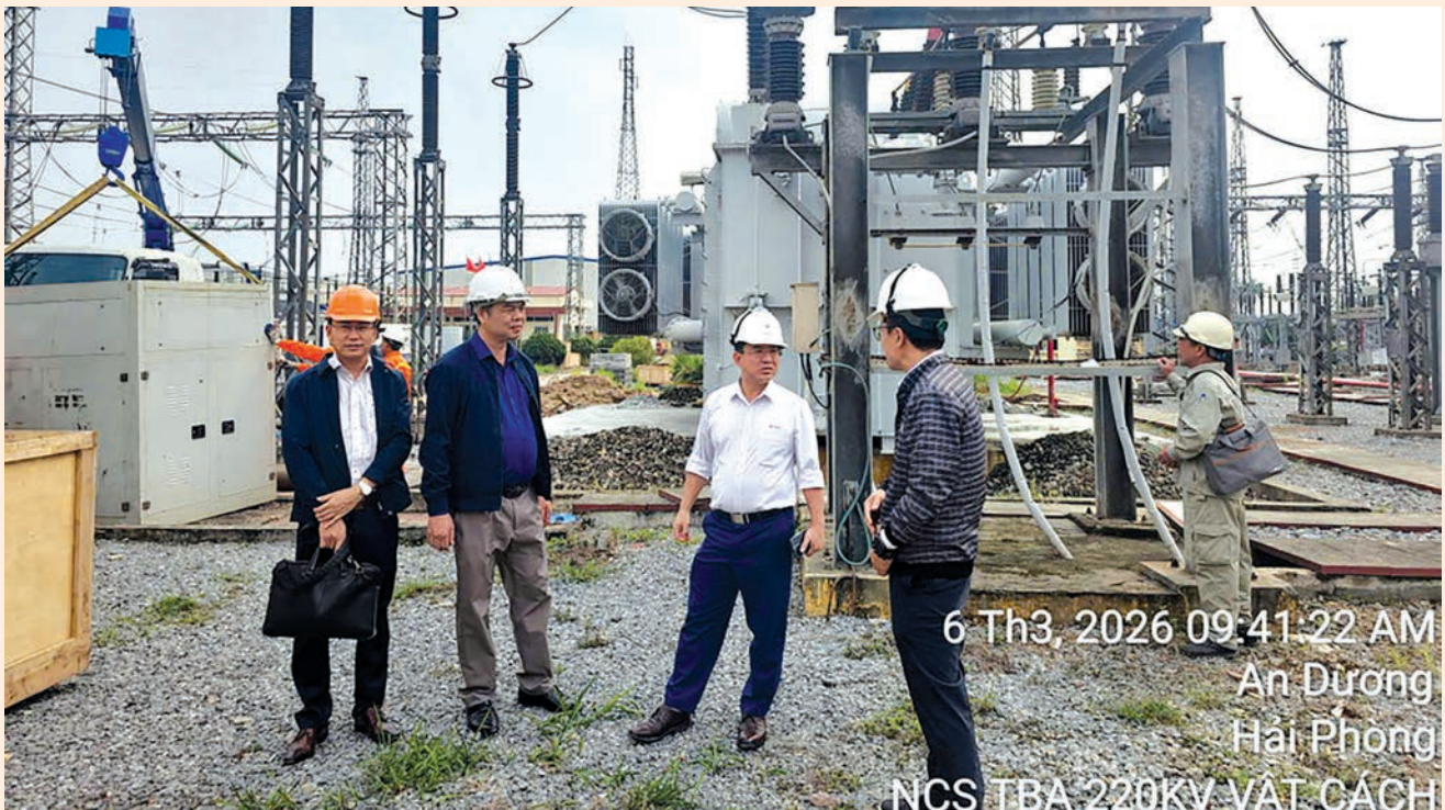
Đoàn kiểm tra công tác thi công tại hiện trường
