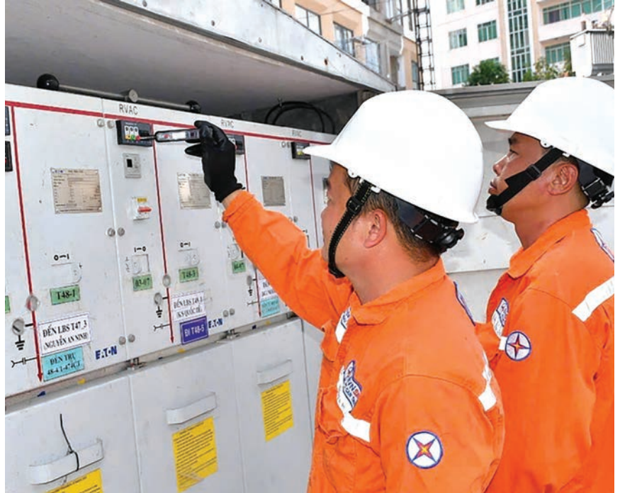
EVNSPC chú trọng đảm bảo điện phục vụ công tác bầu cử tại các xã đảo, đặc khu, khu vực biên giới... trên địa bàn các tỉnh phía Nam. Nguồn ảnh: ĐVCC
