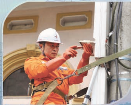
Công nhân PC LANG SƠN thực hiện thay thế công tơ tại TBA Miến Thuố 1.
