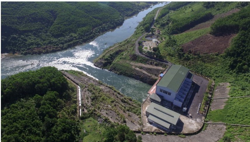
Nhà máy Thủy điện Sông Tranh 2 đang vận hành phát điện an toàn và cấp nước phục vụ sản xuất cho hạ du
