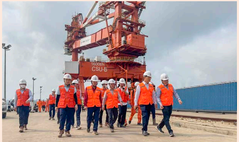
Phó Tổng giám đốc EVN Nguyễn Tài Anh kiểm tra thực tế khu vực cảng nhập than - hạng mục hạ tầng then chốt phục vụ vận hành Nhà máy Nhiệt điện Quảng Trạch I.
