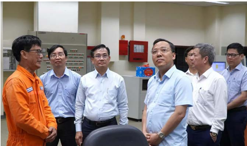
Lãnh đạo Tổng Công ty Phát điện 3 tham gia tiếp đoàn công tác Bộ Công Thương tại Phòng kiểm soát trung tâm Nhà máy điện Phú Mỹ 1
