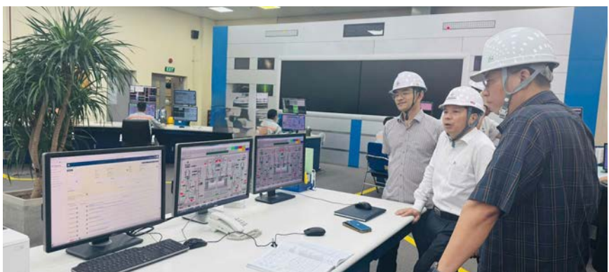
Đoàn công tác kiểm tra công tác vận hành tại phòng điều khiển trung tâm Công ty CP Nhiệt điện Quảng Ninh
