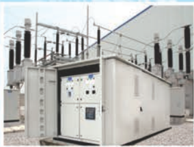
Trạm Kiosk Kiosk substation
