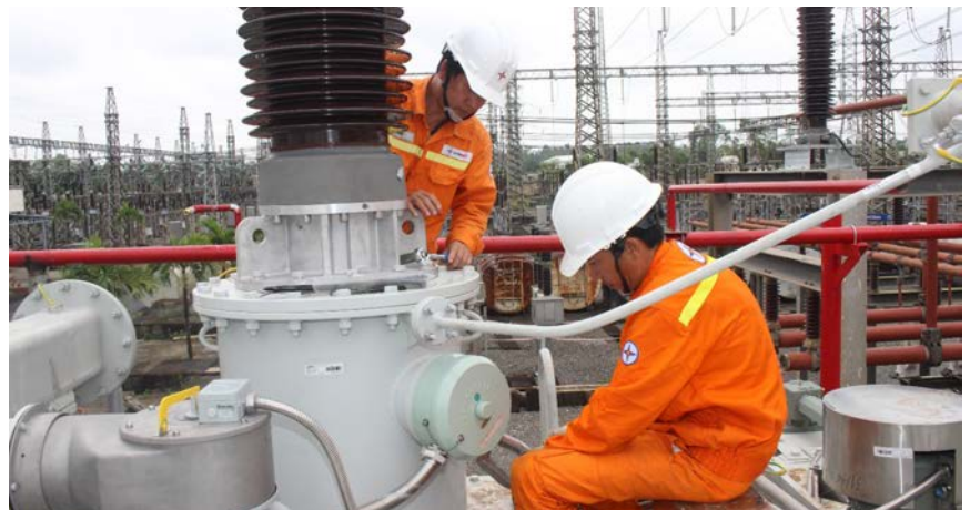
Công nhân PTC2 sửa chữa, bảo dưỡng thiết bị trạm biến áp
