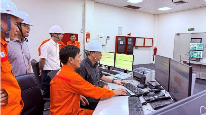
Đoàn công tác kiểm tra công tác vận hành tại Nhà điều khiển trung tâm tổ máy 300MW của Công ty Nhiệt điện Uông Bí
