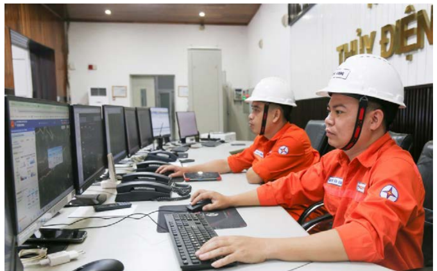
Ca trực vận hành phát điện an toàn và cấp nước cho hạ du tại Nhà máy Thủy điện Sông Tranh 2
