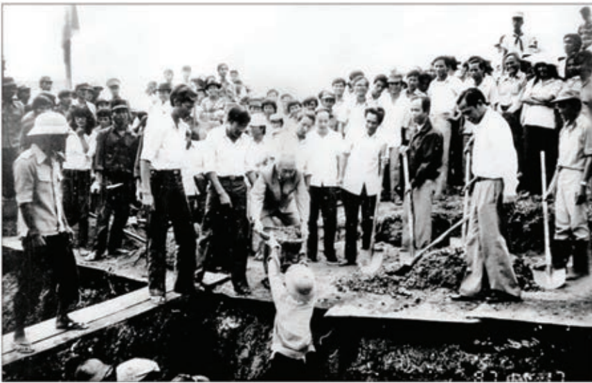
Đại tướng Võ Nguyên Giáp đổ bê tông đầu tiên xây dựng đường dây 110 kV Huế - Đà Nẵng (năm 1987)
