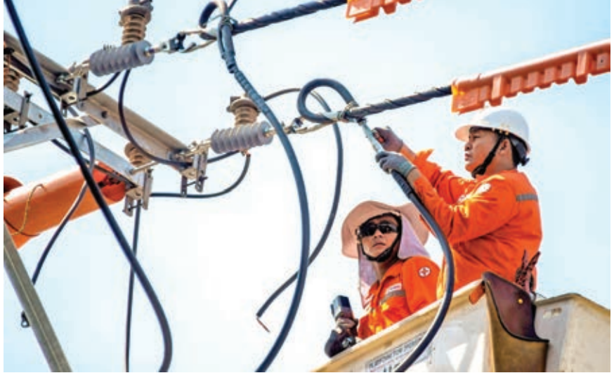
EVNSPC tăng cường công tác kiểm tra an toàn lưới điện tại hiện trường
