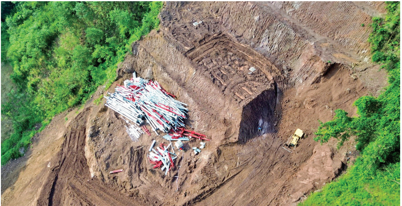
VT 105 đường dây 500kV Lào Cai - Vĩnh Yên do đội TTĐ Đồng Bắc 1 tham gia thi công
