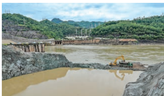
Các hạng mục thuộc tuyến năng lượng như: cửa lấy nước, kênh dẫn vào, đường hầm dẫn nước,... đã được thi công cơ bản hoàn thành theo thiết kế được duyệt, chất lượng thi công đáp ứng yêu cầu.
