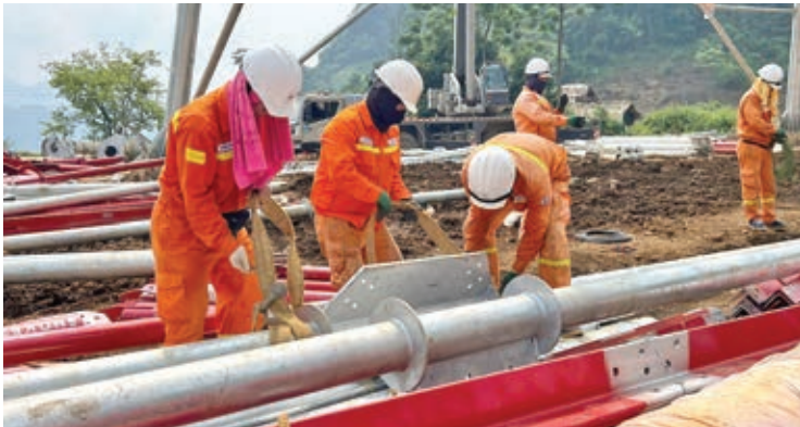
Công ty Truyền tải điện 1 triển khai dựng cột Dự án đường dây 500kV Lào Cai - Vĩnh Yên
