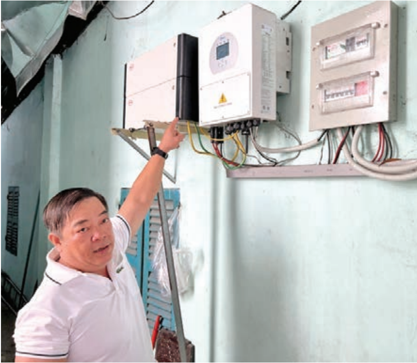
Anh Nguyễn Minh Hiếu giới thiệu bộ lưu điện cho hệ thống điện mặt trời tự dùng
