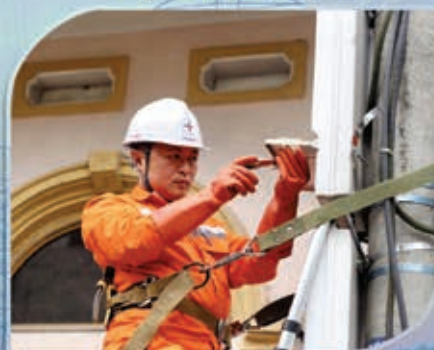
Công nhân PC LẠNG SƠN thực hiện thay thế công tơ tại TBA Miến Thuố 1.
