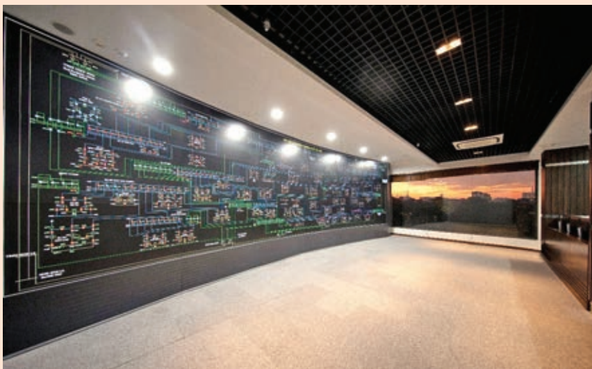
Hình ảnh hệ thống giám sát tại Trung tâm Điều độ hệ thống điện TP Hà Nội
