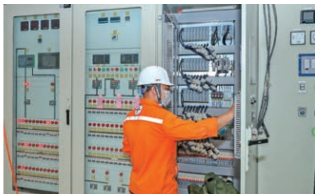
Kỹ sư Công ty TNHH MTV Thí nghiệm điện miền Bắc thực hiện công tác thí nghiệm điện
