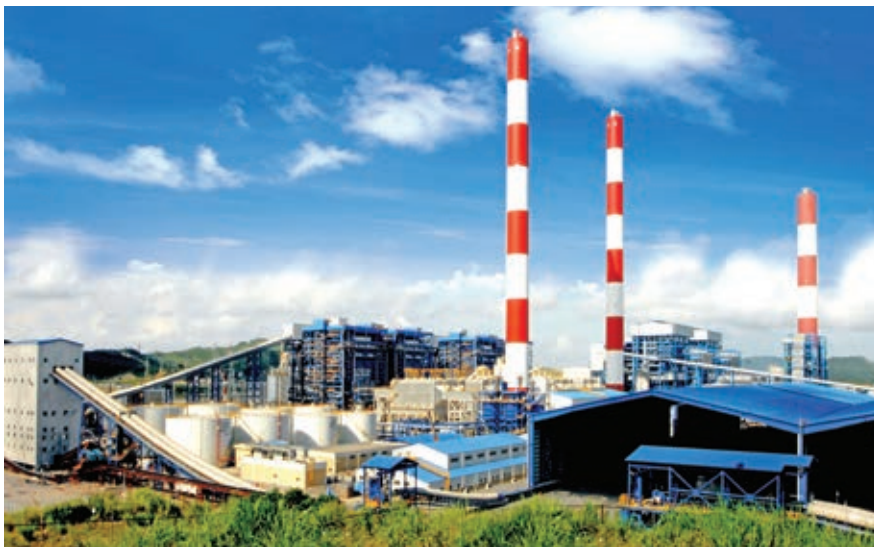
Toàn cảnh Nhà máy Nhiệt điện Mông Dương 1
