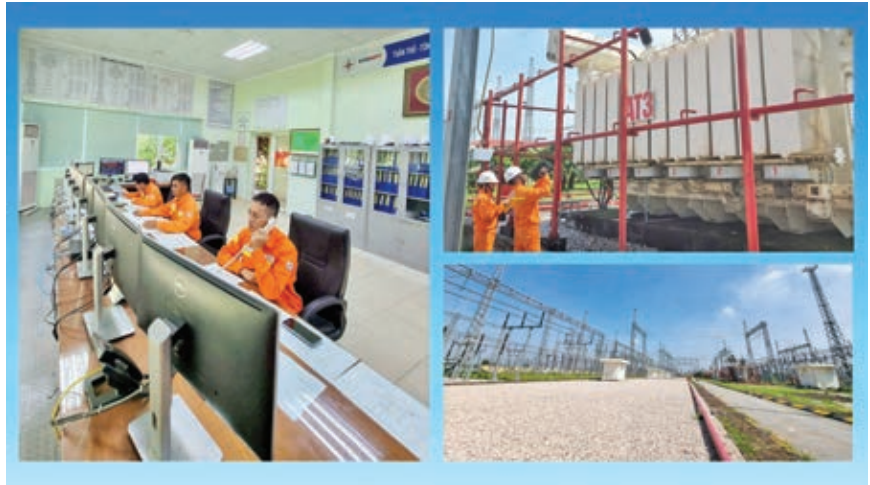
Những phút QLVH căng thẳng - Kiểm tra, soi phát nhiệt, thiết bị ngoài trời tại TBA 500kV Tây Hà Nội
