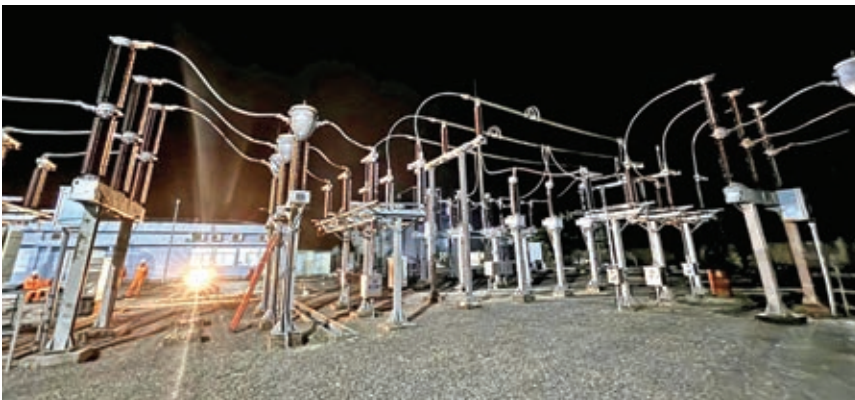
Hạng mục công trình "Ngăn 171, 112 tại Trạm 110kV Phú Quốc, tỉnh An Giang thuộc công trình Đường dây 110kV Phú Quốc – Nam Phú Quốc" vừa hoàn thành đóng điện ngày 2/7/2025
