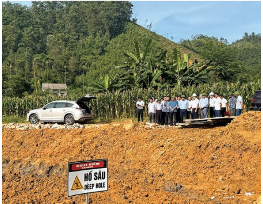
Lãnh đạo UBND tỉnh Phú Thọ và lãnh đạo EVN kiểm tra thi công tại vị trí VT306
