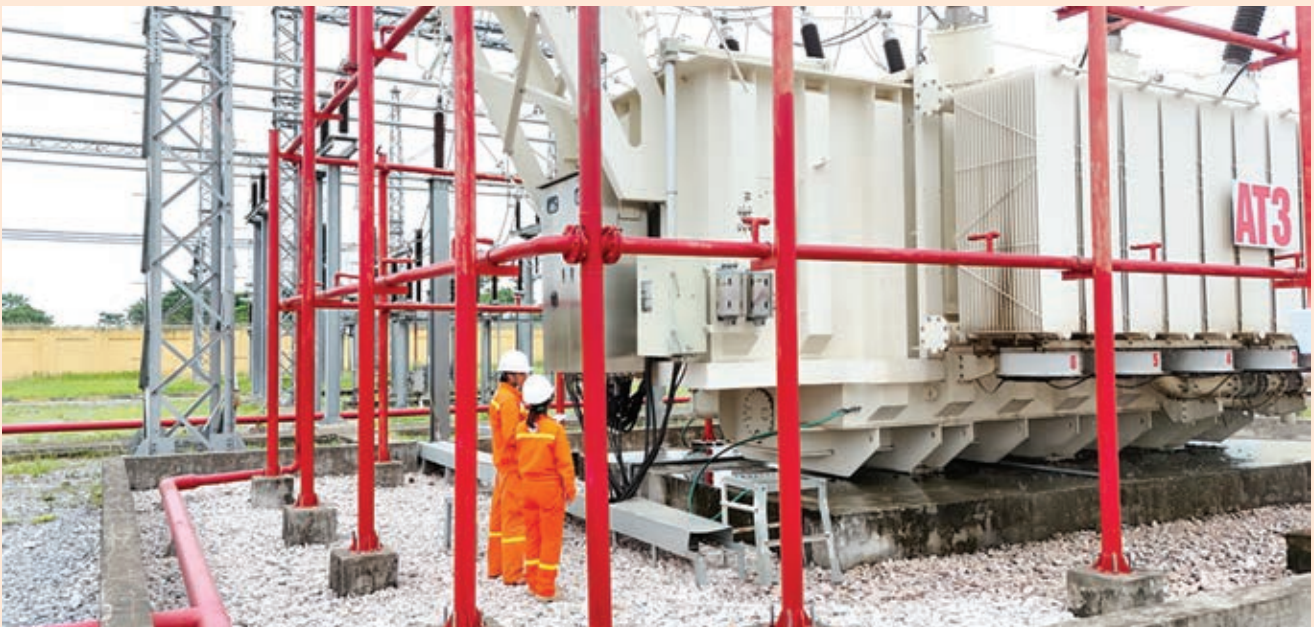
Công nhân truyền tải điện tăng cường kiểm tra thiết bị ngoài trời
