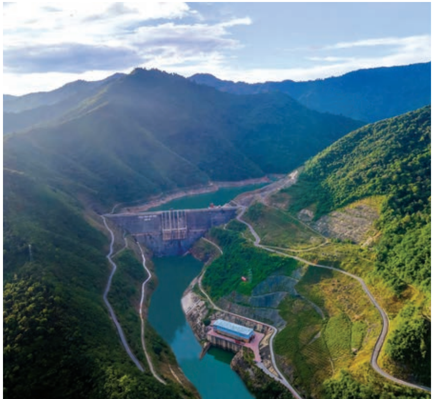
Nhà máy Thủy điện Bản Vẽ cắt tới 93% lưu lượng đỉnh lũ sông Cả trong đợt mưa lớn kéo dài từ ngày 29- 30/5/2025
