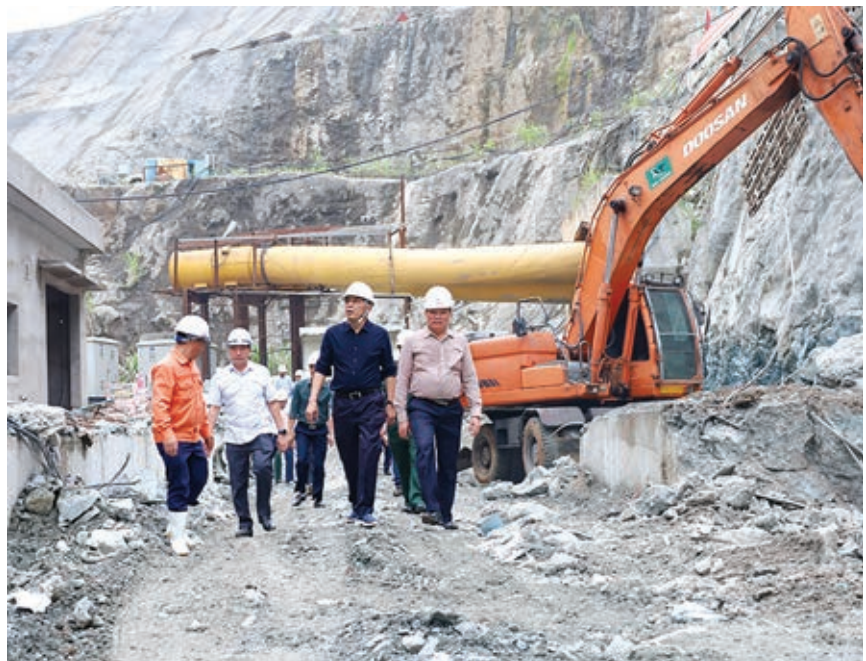
Chủ tịch HĐTV EVN Đặng Hoàng An kiểm tra khu vực thượng lưu nhà máy, phạm vi lắp đặt máy biến áp 500kV
