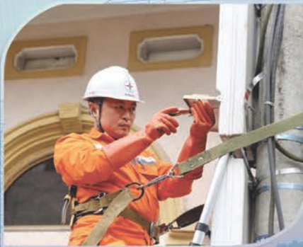
Công nhân PC LẠNG SƠN thực hiện thay thế công tơ tại TBA Miền Thuận 1.
