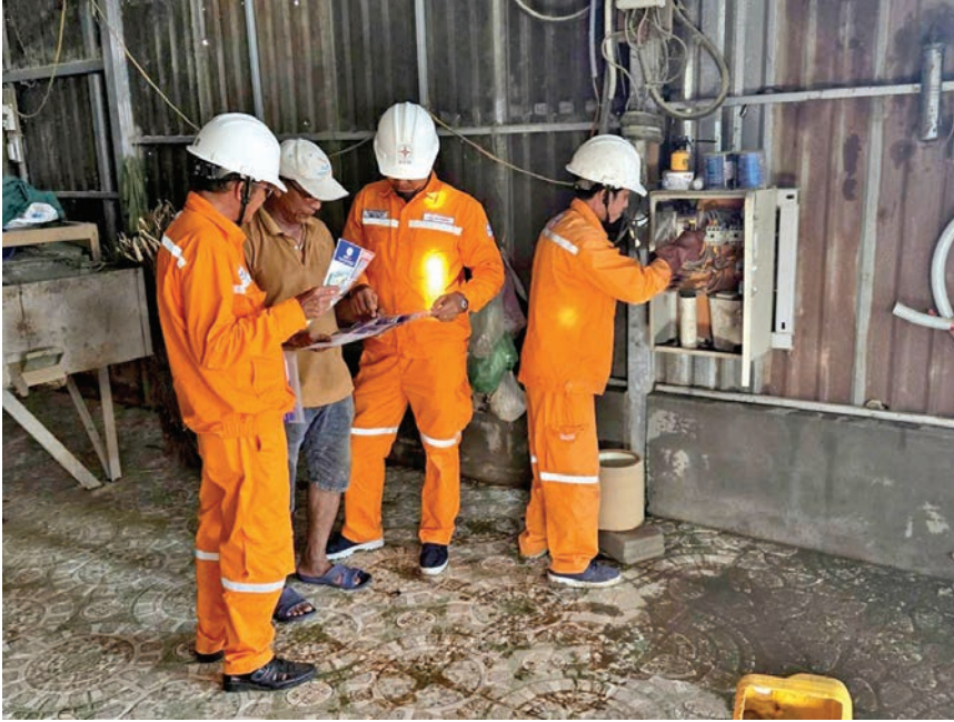
Công ty Điện lực Lâm Đồng kiểm tra hệ thống điện sau công tơ và hướng dẫn người dân vùng lũ sử dụng điện an toàn
