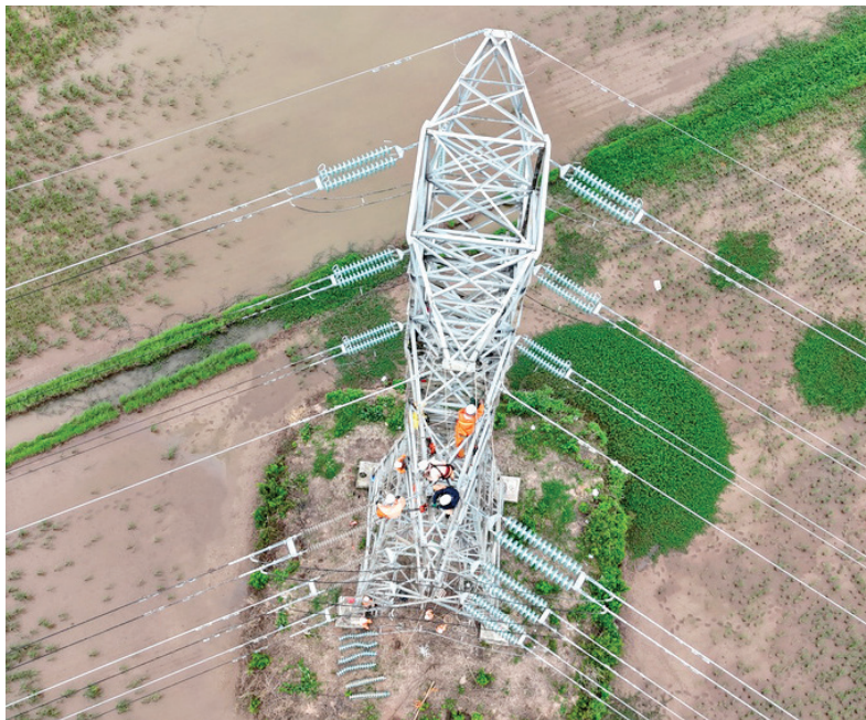
Vị trí cột số 86, ĐZ 272 A11.10 Nhiệt Điện Thái Bình 2 - 273 E3.20 Trục Ninh, do đội TTD Đông Bắc 2 thi công
