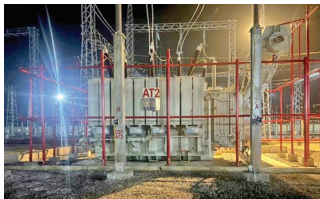
Máy biến áp AT1 220 kV-250 MVA trạm biến áp 220 kV Gia Lộc (Hải Phòng)
