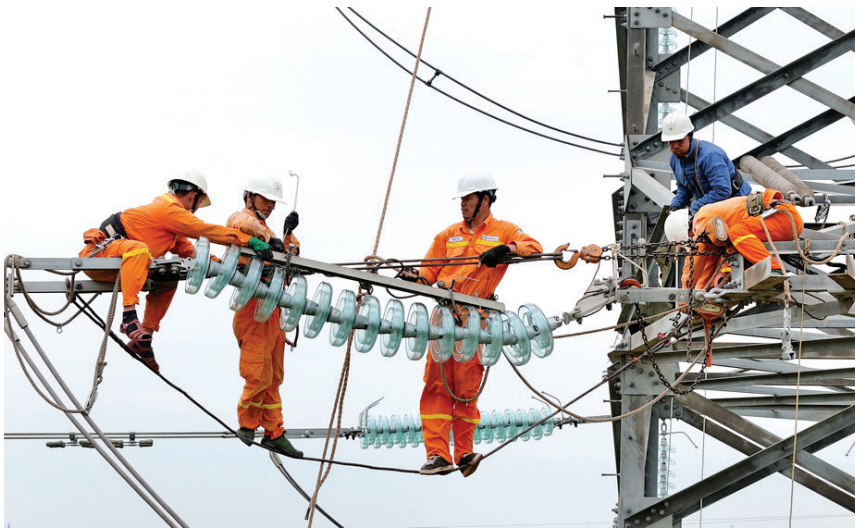
Khẩn trương thi công kịp tiến độ trả điện theo đúng kế hoạch
