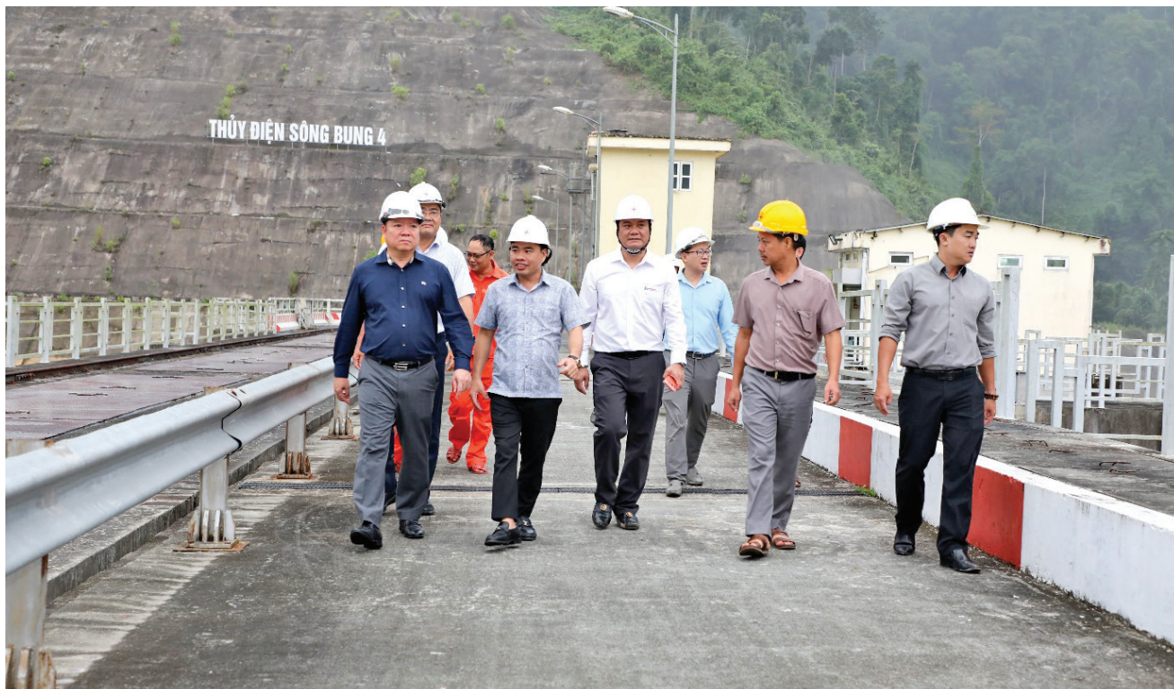
Đoàn công tác tại đập dâng Nhà máy Thủy điện Sông Bung 4 (ảnh: Thanh Danh)
