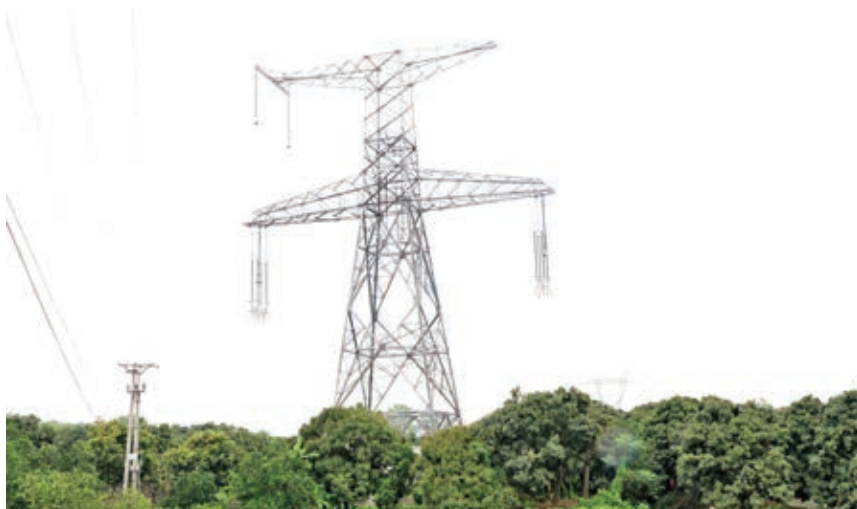
Một khoảng cột Dự án đường dây 500/220kV Nho Quan - Phú Lý - Thường Tín chưa thể kéo dây do vướng mắc mặt bằng
