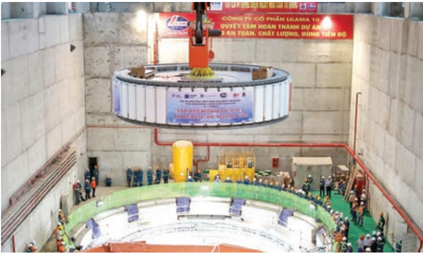
ROTOR tổ máy số 2 được hạ đặt thành công
