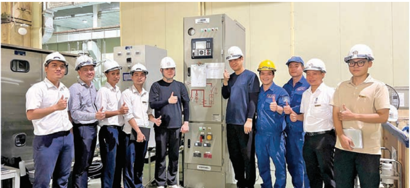
Kỹ sư Vitzro và EEMC tiến hành nạp khí, thí nghiệm thiết bị GIS khí khô tại phòng thí nghiệm EEMC trước khi lắp đặt
