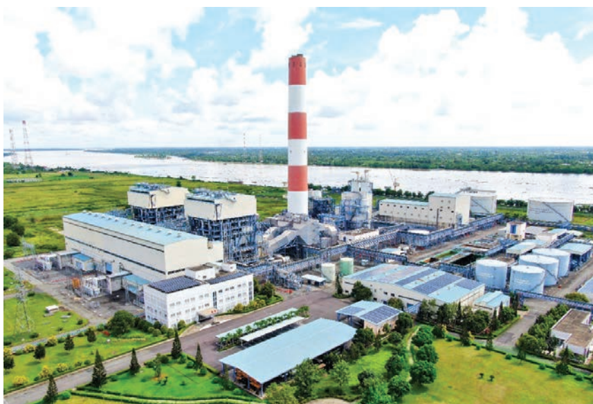
Dự án chuyển đổi nhiên liệu Nhà máy Nhiệt điện Ô Môn I sử dụng khí Lô B-Công ty Nhiệt điện Cần Thơ, công suất 660 MW.
