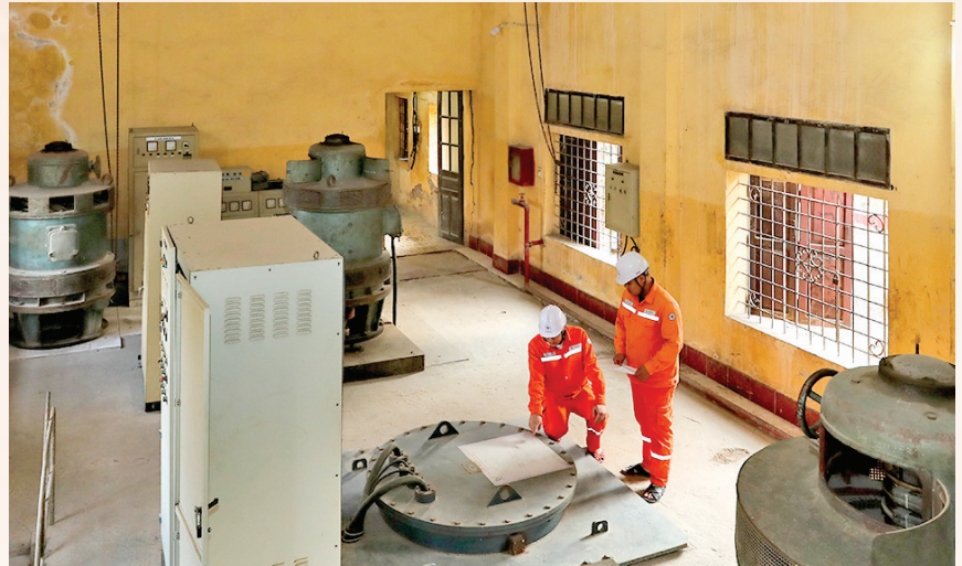
Nhân viên Công ty Điện lực Hưng Yên kiểm tra điện tại trạm bơm Thống Nhất (tỉnh Hưng Yên)
