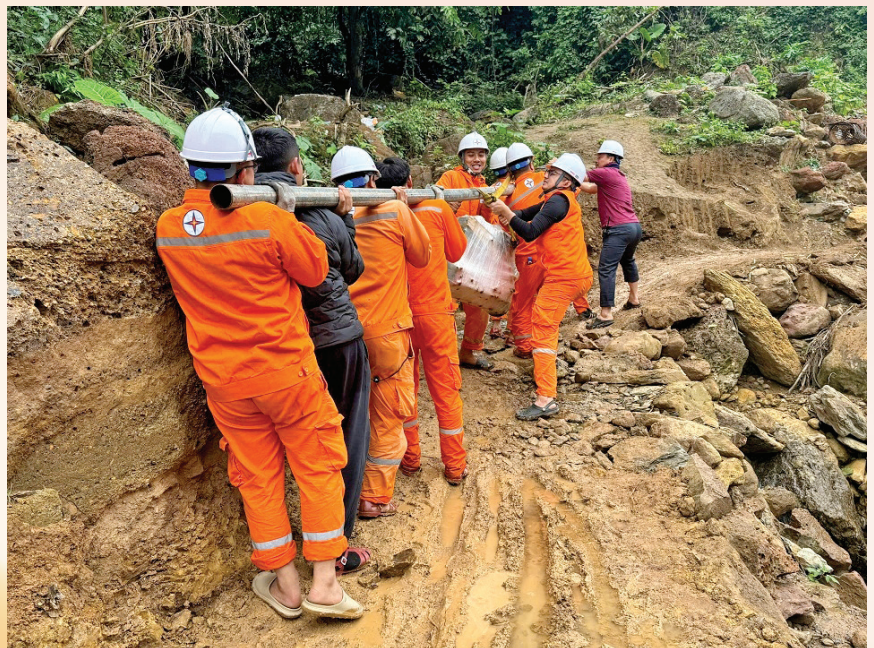
CBCNV Công ty Điện lực Nghệ An trực tiếp vác vật tư, thiết bị, men theo vách núi hiểm trở để đưa điện về vùng sâu
