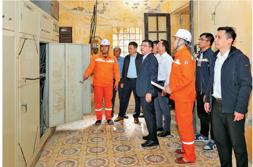
Đoàn công tác kiểm tra hệ thống điện trong trạm bơm Thống Nhất (tỉnh Hưng Yên)
