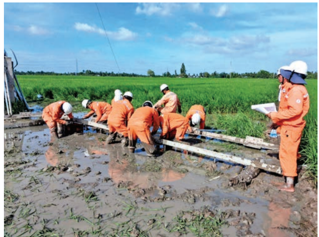
Lực lượng công nhân EVNSPC được điều động chi viện cho các công trình đầu tư xây dựng vào những ngày cuối năm 2025, để đưa các dự án kịp về đích đúng tiến độ
