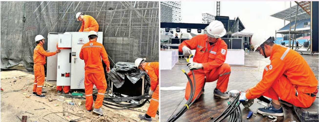
Cán bộ nhân viên Công ty Điện lực Từ Liêm thực hiện lắp đặt các thiết bị phục vụ đảm bảo điện cho khu vực Sân vận động Quốc gia Mỹ Đình ngày 16/1/2026.
