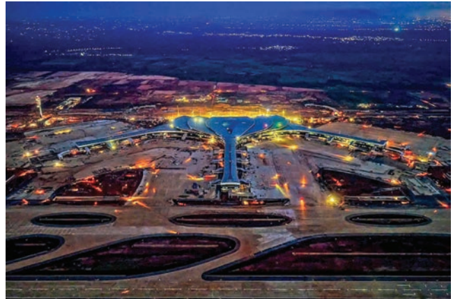
Công trình Trạm biến áp 110kV sân bay Long Thành và đường dây đấu nối vừa được khánh thành trong tháng 12/2025 - đánh dấu bước hoàn thiện quan trọng về hạ tầng điện phục vụ Cảng hàng không Quốc tế Long Thành
