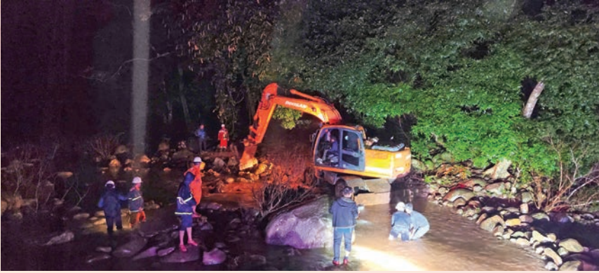
CBCNV Công ty Điện lực Quảng Trị thi công xuyên đêm để “phủ điện” bản Dốc Mây (Quảng Trị)
