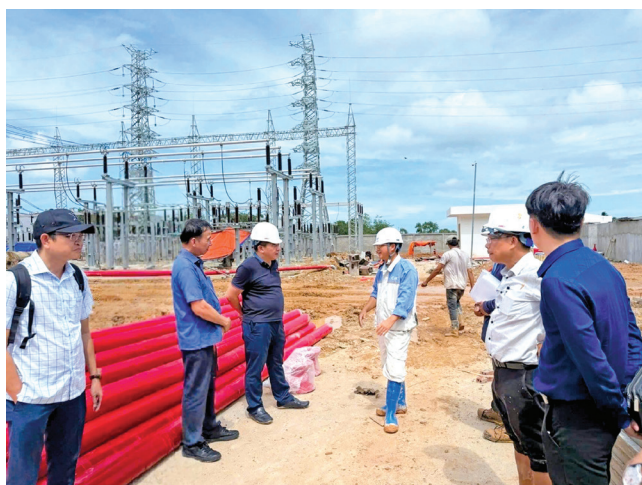
Chủ tịch HĐTV EVNSPC Lê Văn Trang (thứ 3 từ trái sang) kiểm tra công trường Dự án Trạm biến áp 220kV Phú Quốc
