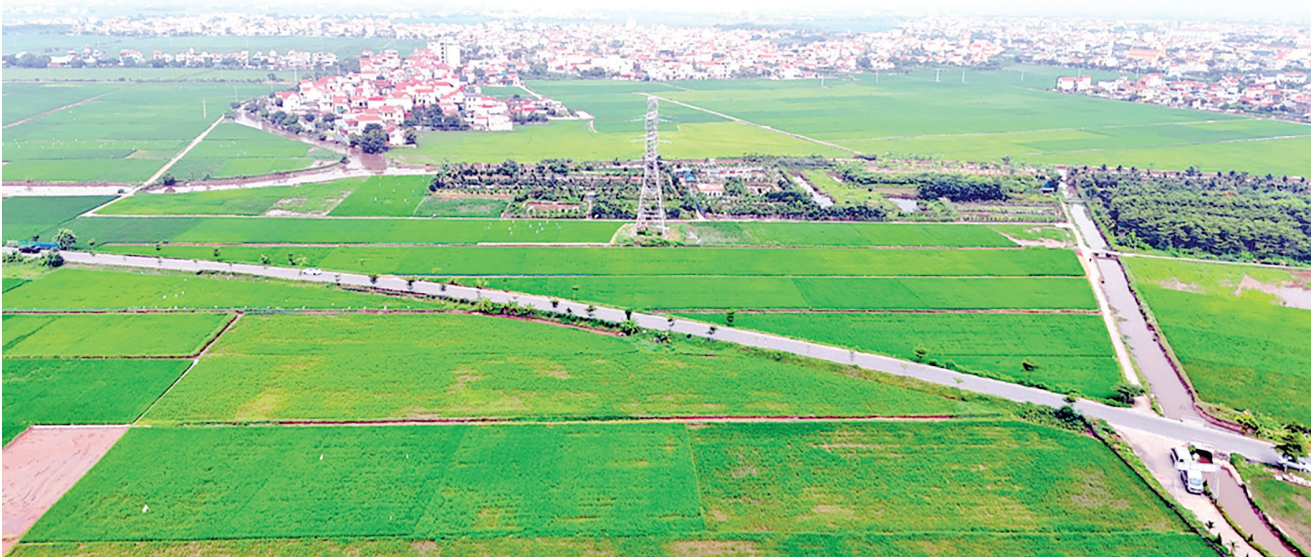
Vị trí cột 73, đường dây 220kV Nhiệt điện Thái Bình 2 – Trục Ninh nhìn từ trên cao
