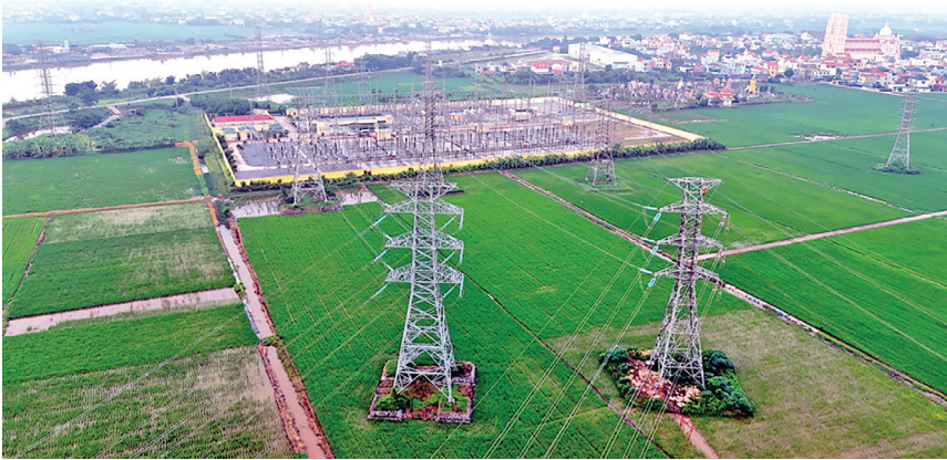
Xuất tuyến đường dây 220kV Nhiệt điện Thái Bình 2 – Trực Ninh tại TBA 220kV Trực Ninh do TTĐ Hà Tĩnh tham gia thi công
