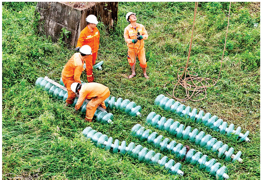
Chuẩn bị đưa chuỗi sứ lên thay thế tại vị trí cột 111 đường dây 220kV Nhiệt điện Thái Bình 2 – Trực Ninh
