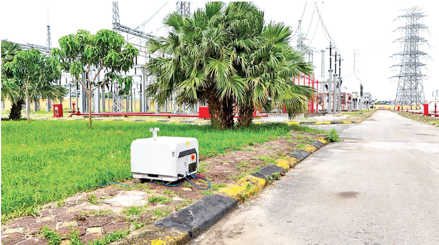
Trạm Dock điểm UAV quay trở về điểm xuất phát, tự động sạc pin, đồng bộ dữ liệu lên hệ thống
