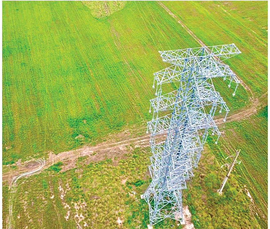
Cột và đường dây hỗn hợp 110 - 220kV thuộc Dự án đường dây 220kV Chơn Thành - Bến Cát
