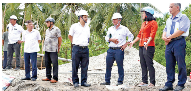
Phó Tổng giám đốc EVNSPC Bùi Quốc Hoan (chính giữa) có mặt tại TP Cần Thơ để kiểm tra, dồn đốc tiến độ các dự án điện trên địa bàn thành phố
