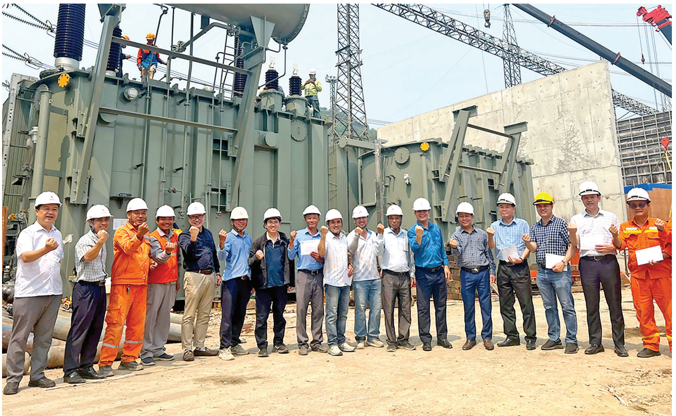
Công đoàn EVNNPT tiếp sức công trường, thúc đẩy Dự án nâng công suất TBA 500kV Hòa Bình về đích đúng hạn
