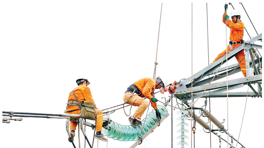
TTĐ Hà Tĩnh nỗ lực thi công trả điện đúng giờ theo phương án đã đề ra tại vị trí cột 73, đường dây 220kV Nhiệt điện Thái Bình 2 – Trục Ninh
