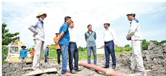
Thành viên HĐTV EVNSPC Lê Hoàng Oanh (thứ 2 từ phải sang) đến kiểm tra tiến độ các công trình điện trên địa bàn tỉnh Tây Ninh
