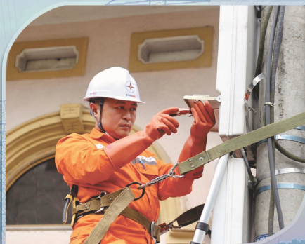
Công nhân PC LẠNG SƠN thực hiện thay thế công tơ tại TBA Miền Thuố 1.
