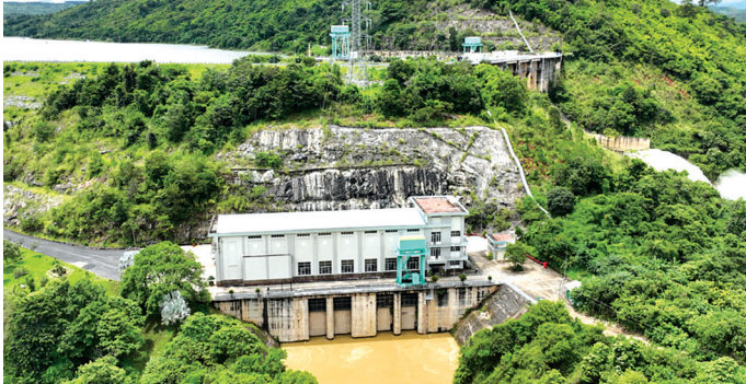
Toàn cảnh Nhà máy Thủy điện Buôn Tua Srah
