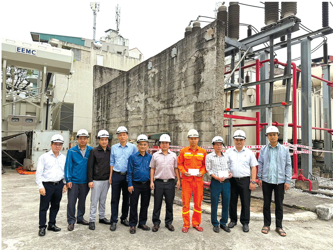
Lãnh đạo PTC1 thăm hỏi động viên CBCNV tham gia thi công đảo chuyển MBA 220kV-250MVA tại TBA 220kV Thành Công
