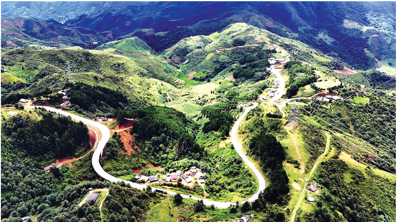
Đường dây 500 kV Sơn La - Lai Châu đoạn qua đèo Pha Đin
