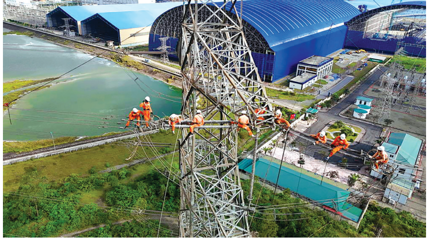
Thay cách điện đường dây 500kV Vũng Áng - Quảng Trị
