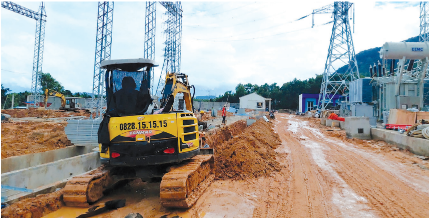
Công trường thi công Trạm biến áp 220kV Phú Quốc
