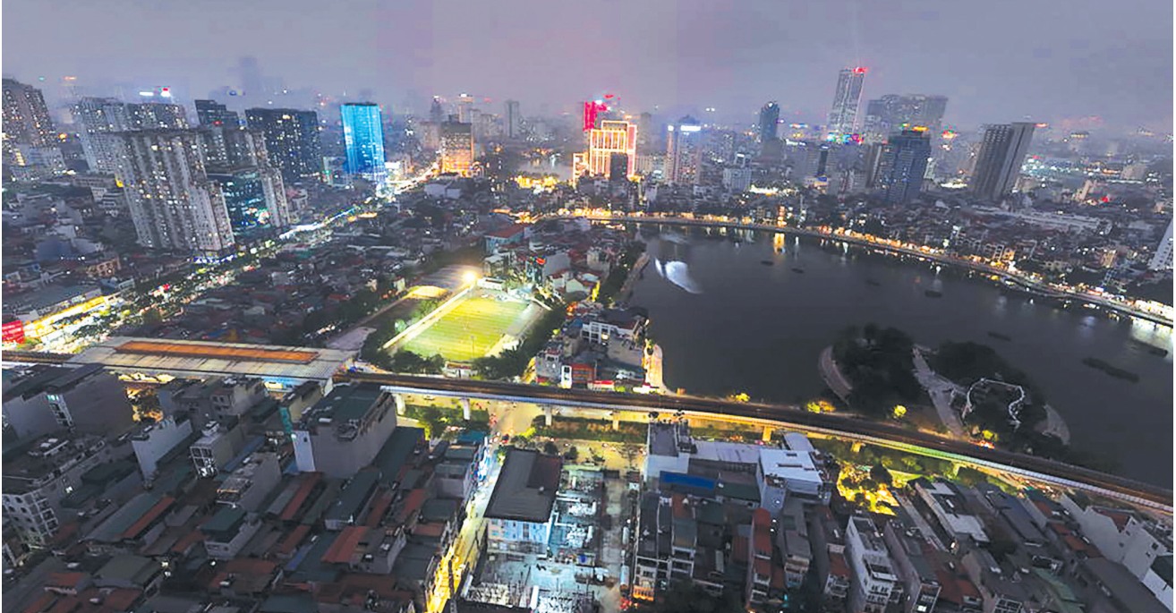
Giữa nhịp sống sôi động của Thủ đô, Trạm biến áp 220kV Thành Công lặng thầm giữ vững dòng điện cho khu vực trung tâm Hà Nội - minh chứng cho 18 năm bền bỉ của EVNNPT.
