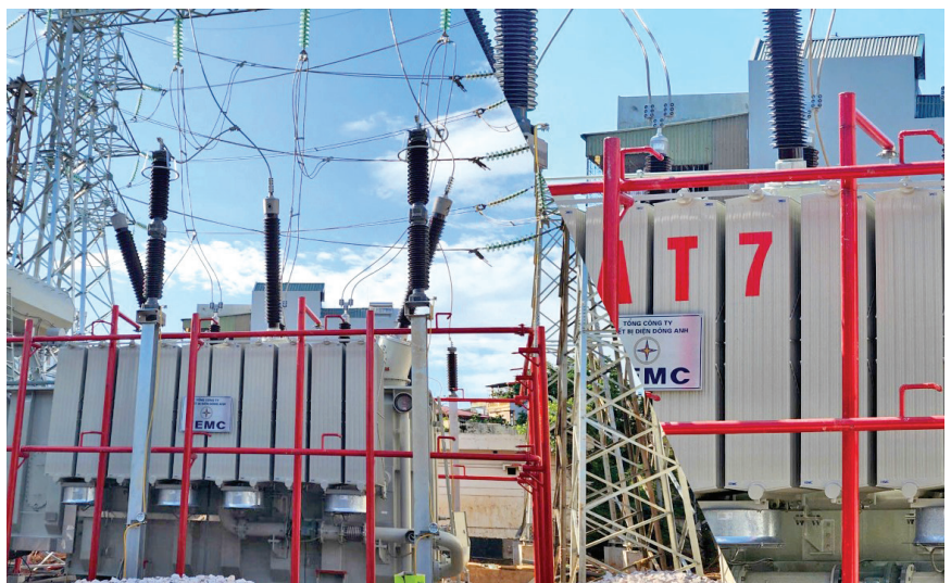
PTC1 kịp thời lắp đặt MBA AT7 tại TBA 220kV Hà Đông trước đỉnh điểm nắng nóng
