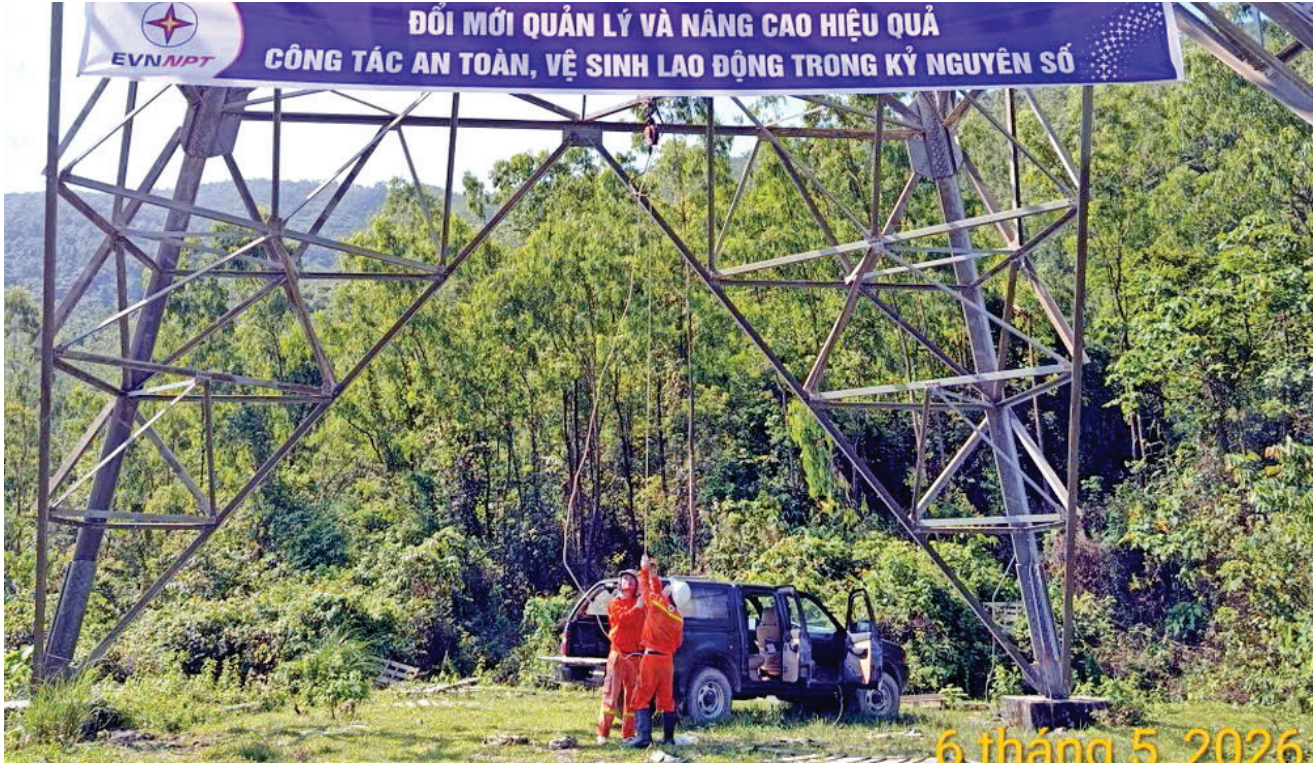
PTC1 thay cách điện đường dây 500kV Bắc Nam, mạch 1 đoạn Hà Tĩnh
