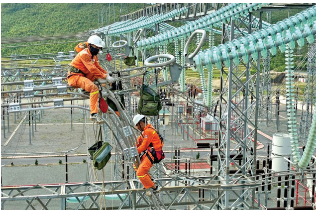
Công nhân PTC2 kiểm tra sửa chữa thiết bị trạm biến áp 500kV
