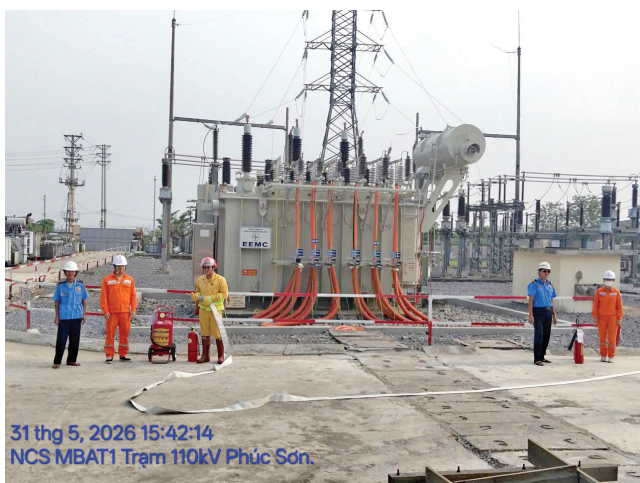
Hình ảnh máy biến áp T1 63 MVA - 115/38,5/23 kV mới.
