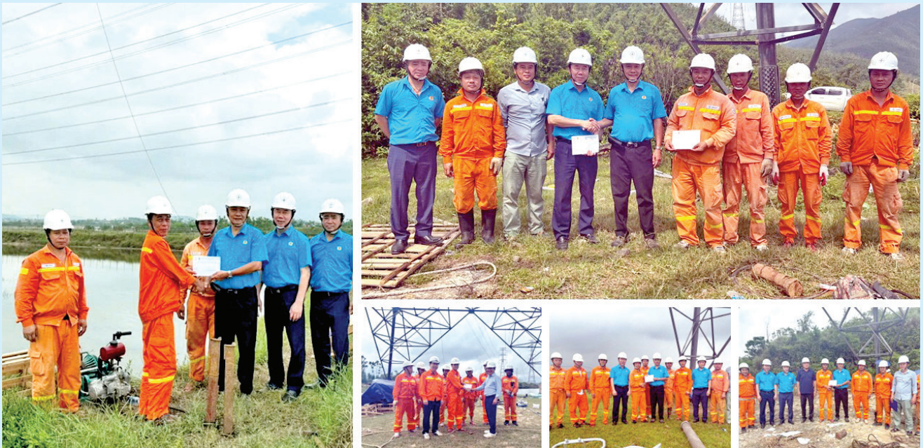
Đoàn công tác Công đoàn PTC1 do ông Nguyễn Toàn Thắng - Chủ tịch Công đoàn dẫn đầu đến tận các vị trí thi công thăm hỏi, trao quà cho các đơn vị tham gia thi công
