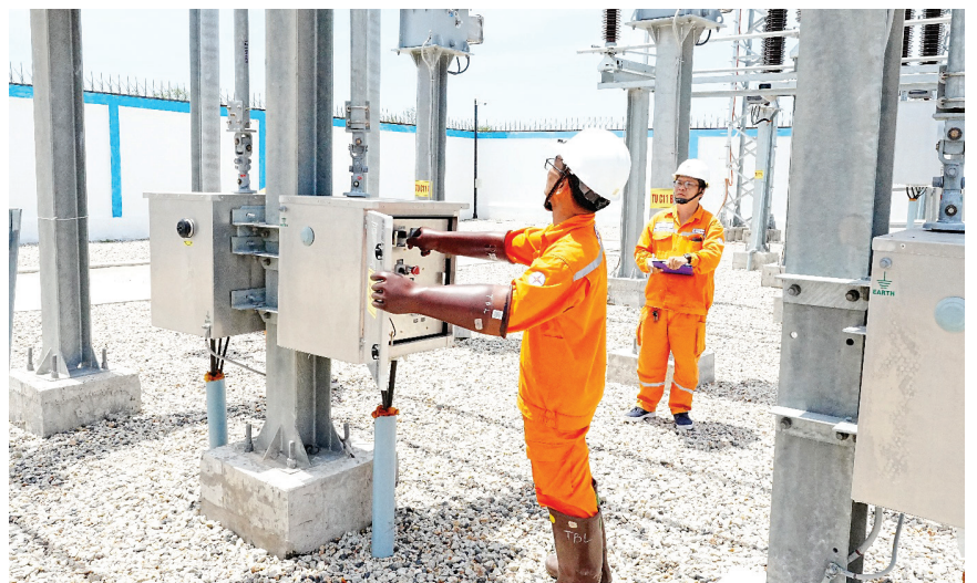
Trong 4 tháng đầu năm 2026, EVNSPC đã đóng điện được 51 công trình lưới điện 110kV (trong ảnh: nhân viên Công ty Điện lực Cà Mau thao tác đóng điện TBA 110kV Hiệp thành và đường dây đấu nối ngày 29/4/2026) (ảnh: Văn Tám)
