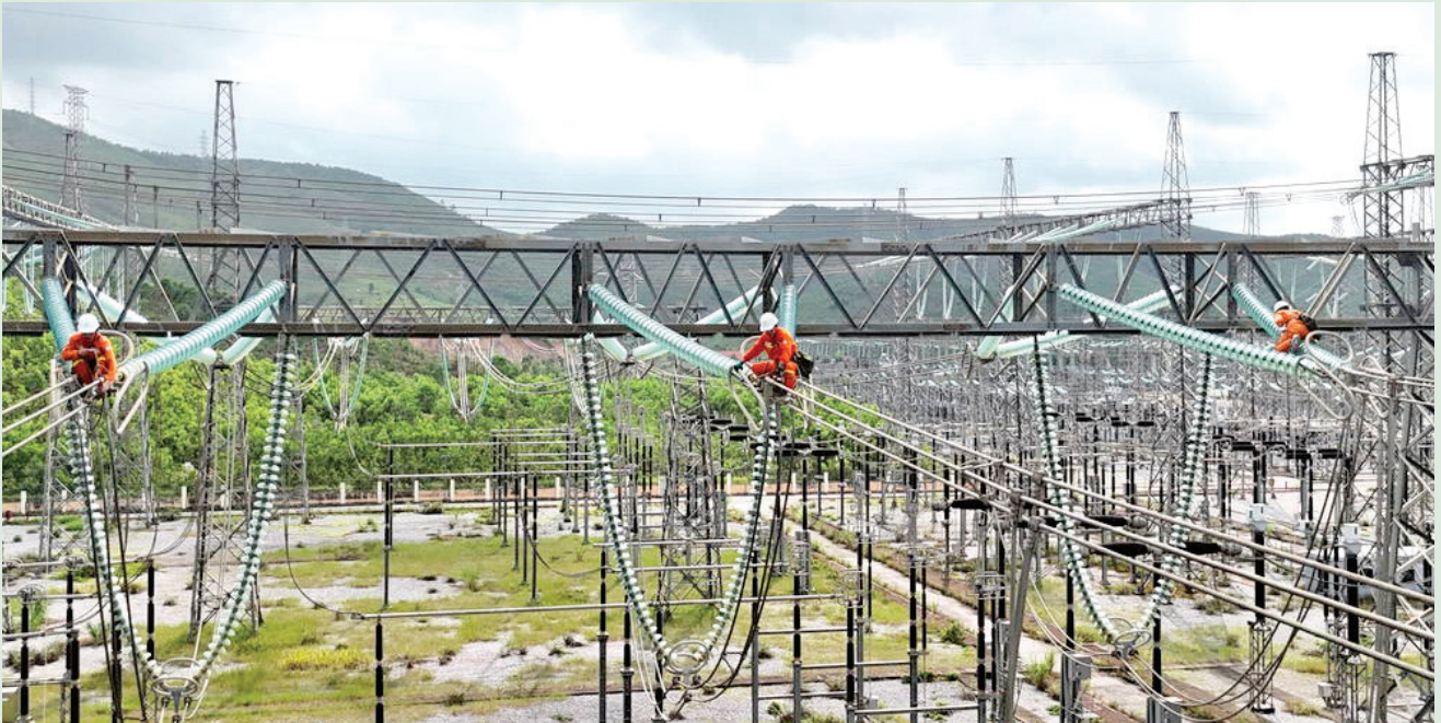
Xử lý khiếm khuyết tại các ngăn lộ xuất tuyến TBA 500kV Quảng Ninh
