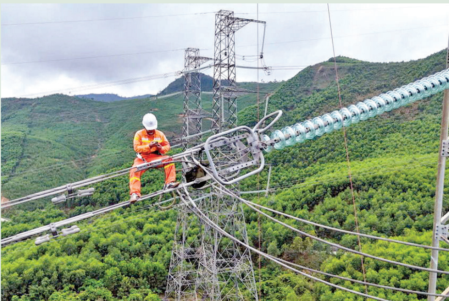
Xử lý khiếm khuyết tại các ngăn lộ xuất tuyến TBA 500kV Quảng Ninh
