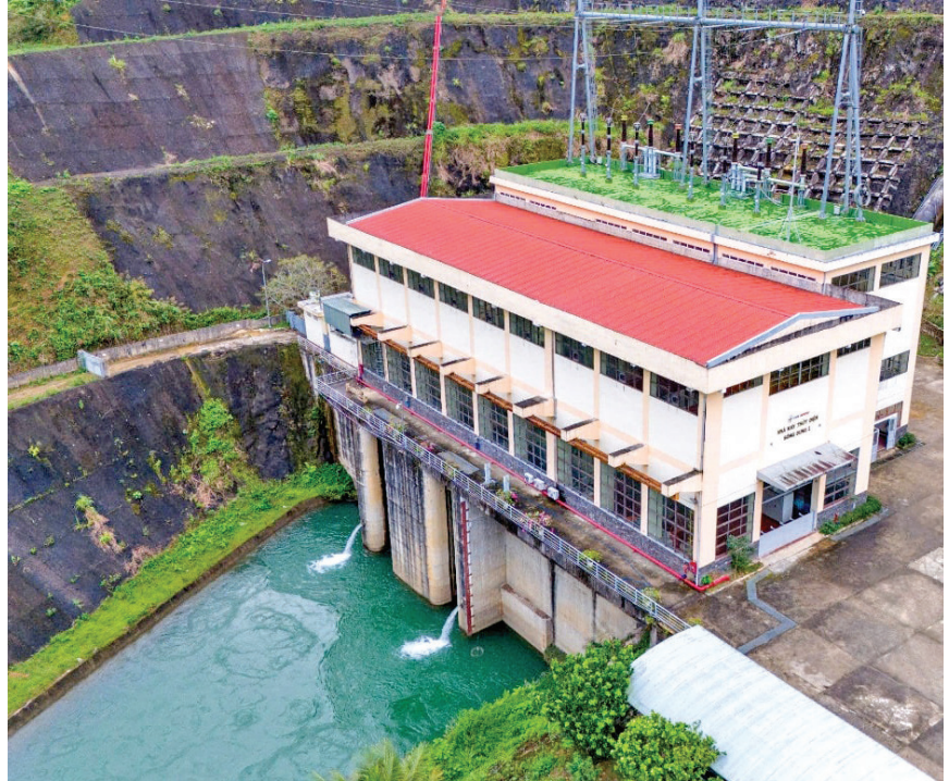
Nhà máy Thủy điện Sông Bung 2, Công ty Thủy điện Sông Bung, huyện Nam Giang, thành phố Đà Nẵng
