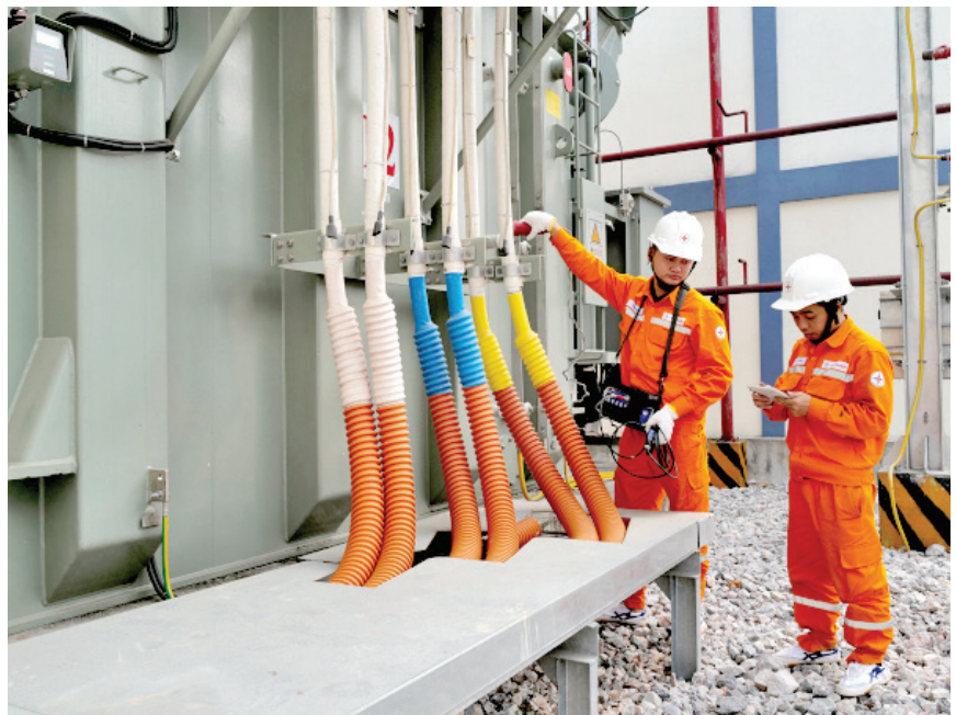
Công nhân làm việc tại trạm biến áp đường Láng Hạ (Hà Nội). Ảnh: Ngọc Thành
