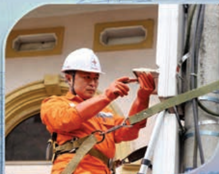
Công nhân PC LANG SƠN thực hiện thay thế công tơ tại TBA Miến Thuố 1.
