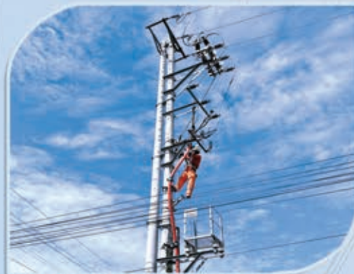
PC HÀ NAM cải tạo nhiều hạng mục, công trình, nâng cấp đường dây lên vận hành 22kV nhằm đảm bảo cung ứng điện an toàn, ổn định.
