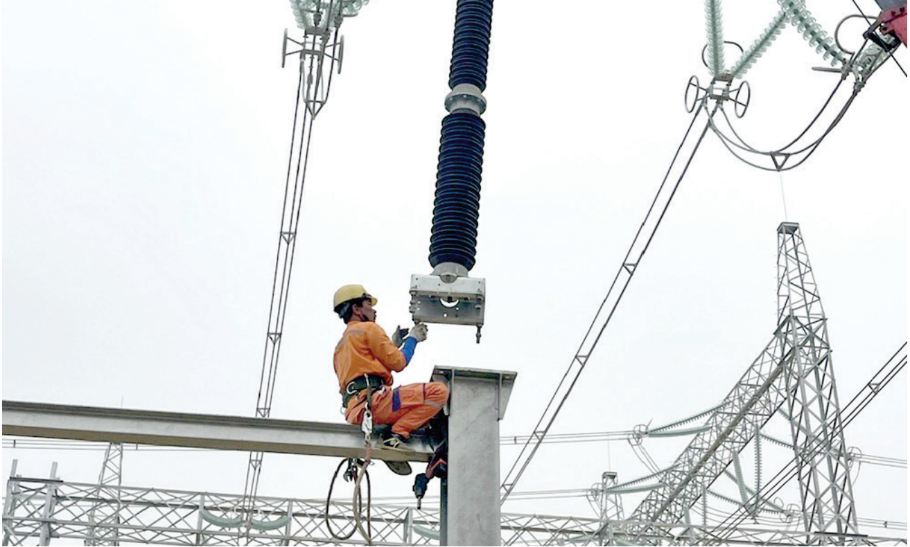
Thi công lắp đặt thiết bị tại TBA 500kV Vinh Yên
