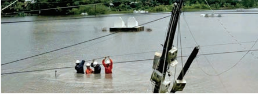
Các công trình, nhà cửa vi phạm HLATLĐCA sẽ rất nguy hiểm (ảnh: PCLA)
