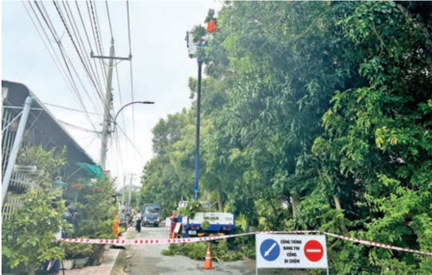
Người dân tạo điều kiện để phía điện lực phát quang, chặt tỉa cành cây gần HLATLĐCA (ảnh: PCĐT)
