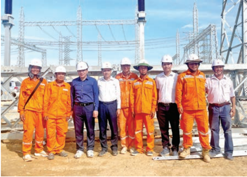
Lãnh đạo EVNSPC thăm, động viên người lao động tham gia thi công Đường dây 500kV mạch 3 từ Quảng Trạch đến Phố Nối
