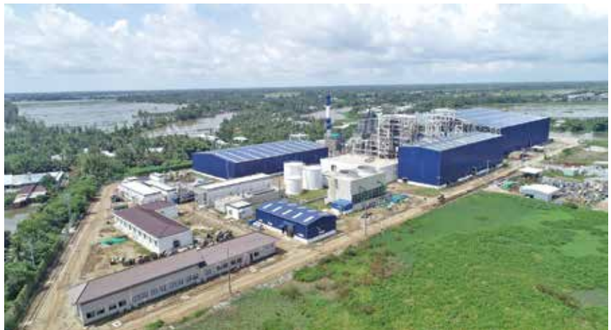
Nhà Máy Điện Sinh Khôi Hậu Giang 2x10MW Tăng Tốc Về Đích
