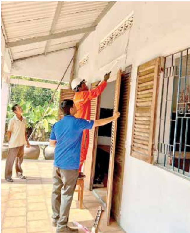
Thực hiện sửa chữa điện, thay thế đèn chiếu sáng bằng đèn LED tiết kiệm năng lượng cho hộ gia đình chính sách tại khu phố Mỹ Hảo, thành phố Thủ Dầu Một
