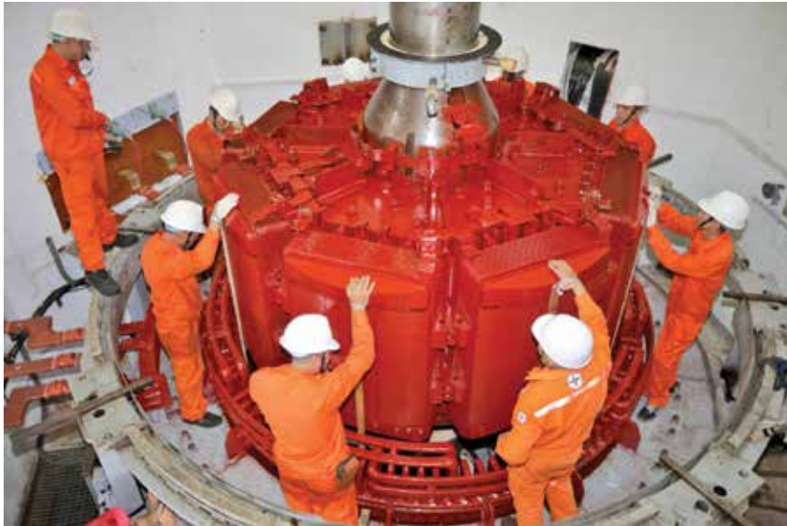
Đơn vị sửa chữa thực hiện nội dung lắp rotor tổ máy phát H2 nhà máy thủy điện Quảng Trị. Ảnh: Minh Lương
