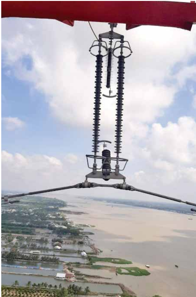
Hình 4- Đặt chống sét van đường dây
