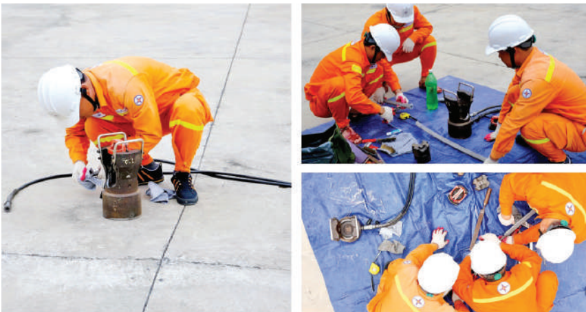
Phần thi thực hành nhóm công nhân nối dây điện cao áp
