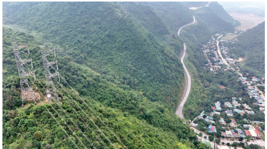
Thi công trong điều kiện rất khó khăn do địa hình núi đá, cao. Vị trí cột 370 ĐZ 500kV Sơn La - Hòa Bình cao trên 400m so với mặt đường Quốc lộ.
