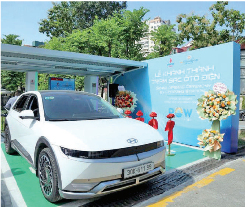
Trạm sạc có công suất 120kW với hai cổng sạc CCS2 tương thích với đa số các dòng xe điện đang có hiện nay
