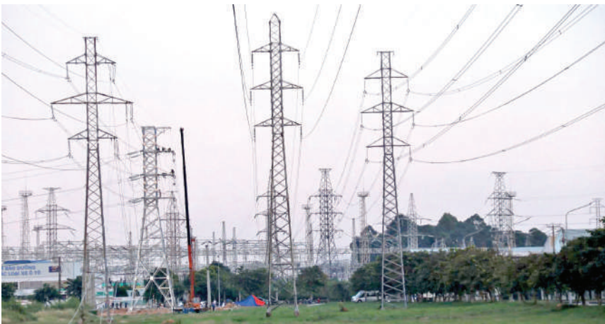
Công trình nâng công suất đường dây 110kV Long Bình – Đồng Nai đóng điện khuya ngày 17/11/2024
