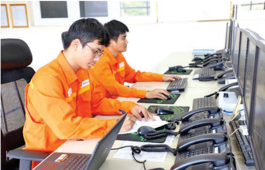
Vận hành viên Nhà máy Srépốc 3 (Công ty Thủy điện Buôn Kuốp) trực vận hành sản xuất điện
