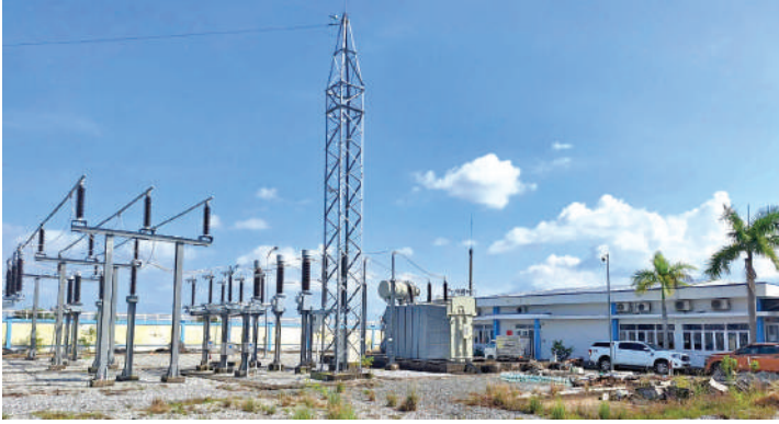
Công trình các lộ ra 110kV Trạm Vĩnh Thuận đã đóng điện ngày 17/11
