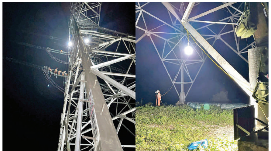
Vận chuyển thiết bị, thi công xuyên tối để về đích sớm
