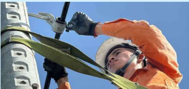
Hoàn chỉnh đấu nối phần đường dây hạ thế
