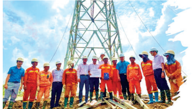
Đ/c Đỗ Đức Hùng - Chủ tịch Công đoàn điện lực Việt Nam thăm hỏi, động viên CBCNV đang thi công khắc phục bão số 3 tại VT cột 15 ĐZ 220kV Ủng Bí - Yên Hưng
