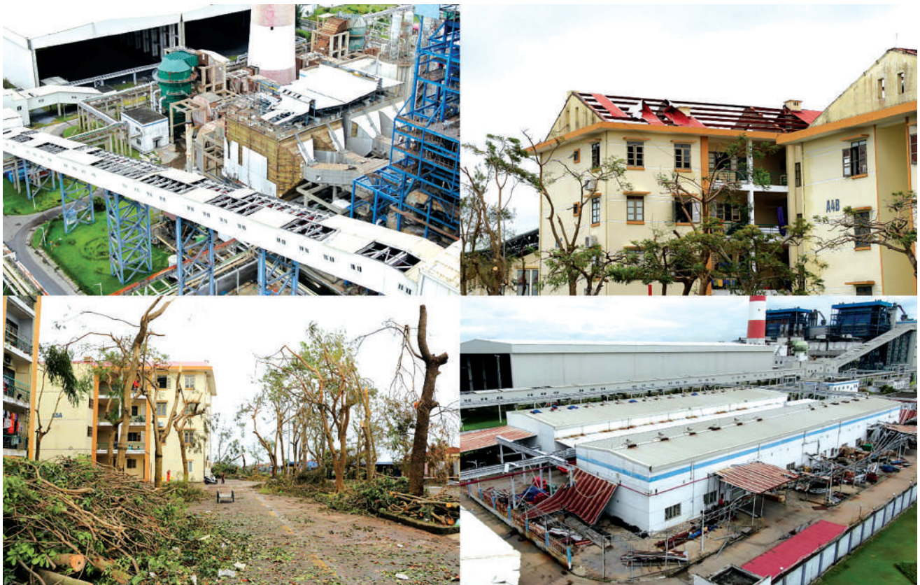
Hình ảnh 02 Nhà máy điện của EVNGENCO2 sau bão số 3
