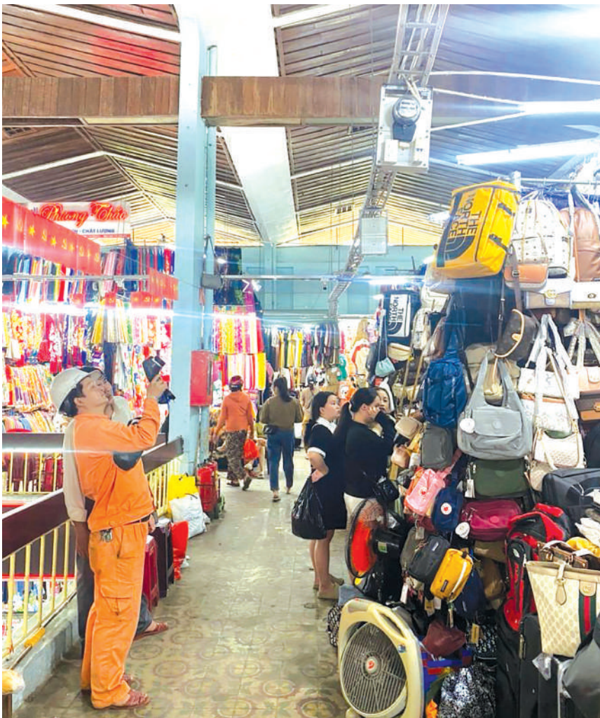
Nhân viên Điện lực kiểm tra rò điện tại chợ Đông Ba
