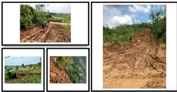
Đường lên vị trí cột 15 ĐZ 220kV Ủng Bí - Yên Hưng nơi lực lượng vận hành PTC1 đang khắc phục sự cố do bão số 3 gây ra
