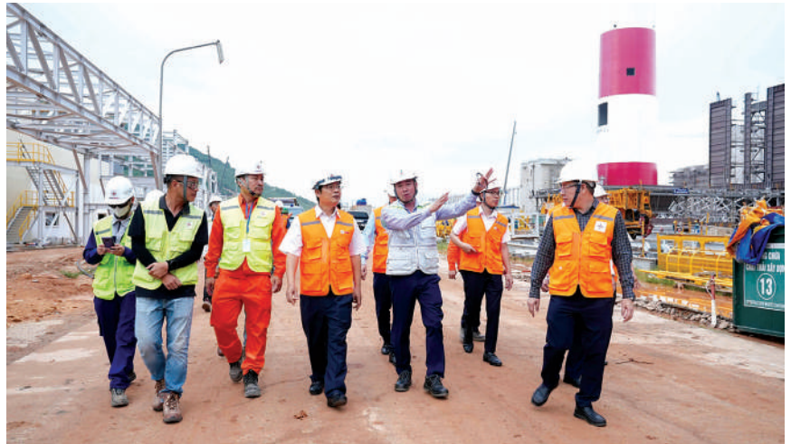
Phó Tổng Giám đốc EVN Nguyễn Tài Anh kiểm tra công trường Nhà máy Nhiệt điện Quảng Trạch 1
