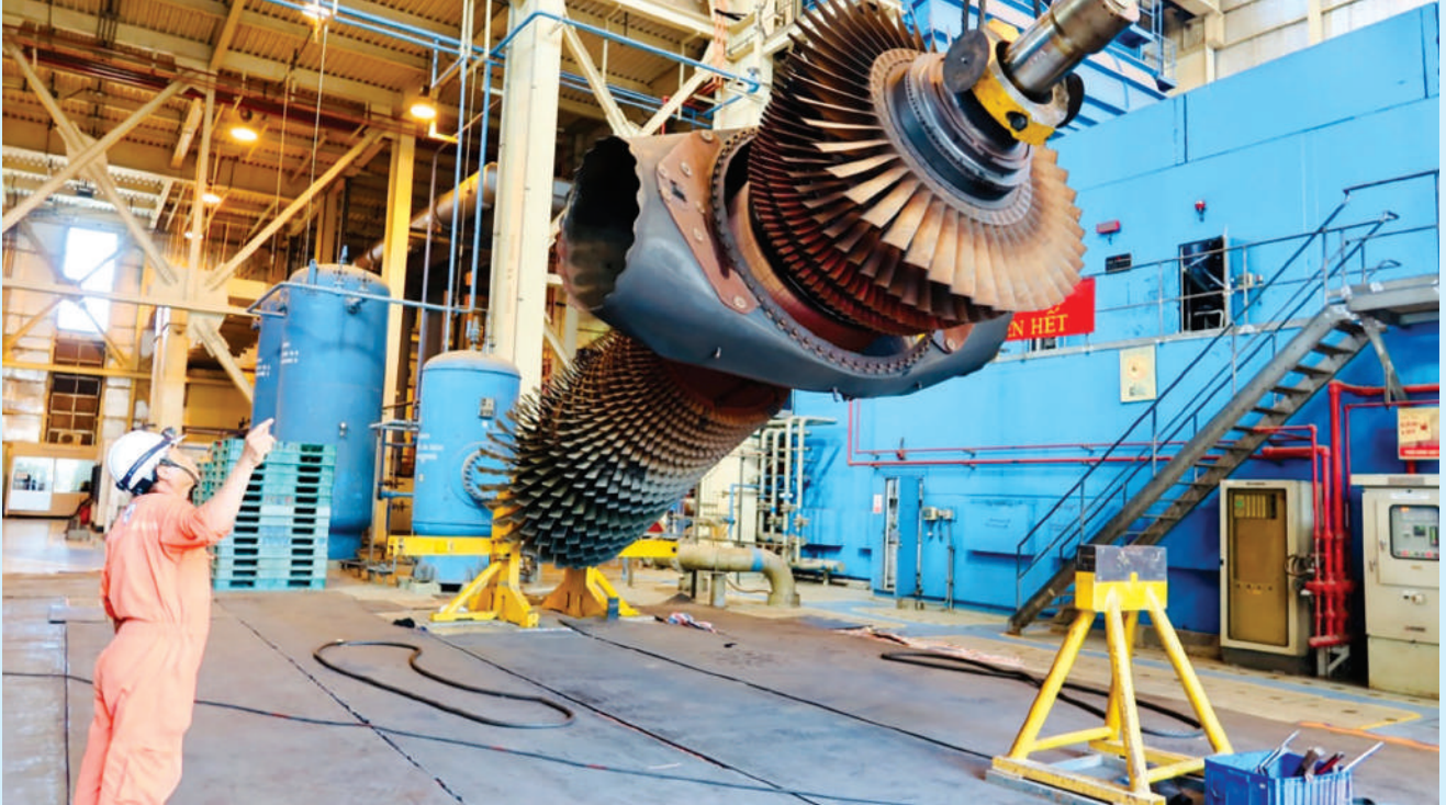
EPS hoàn thành 05 công trình sửa chữa lớn cụm Nhà máy điện Phú Mỹ 2.1 Mở rộng
