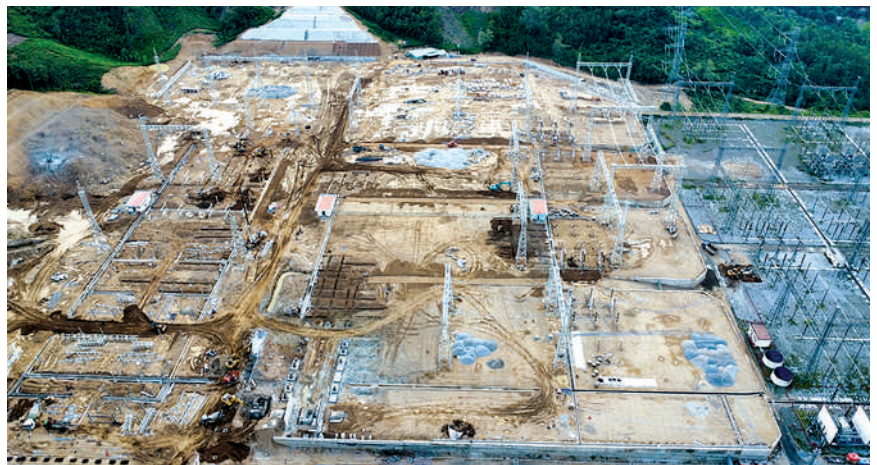
Toàn cảnh Dự án Mở rộng ngăn lộ và cải tạo TBA 500kV Thạnh Mỹ
