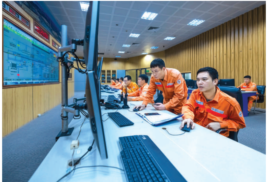
Nhân viên vận hành Nhà máy Nhiệt điện Hải Phòng tập trung quan sát các thông số
