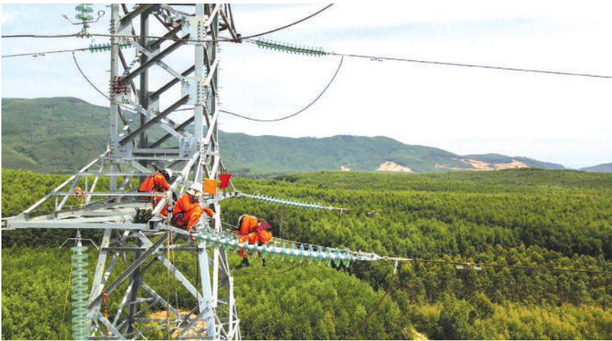
Công nhân PTC2 tích cực sửa chữa, bảo dưỡng thiết bị đường dây truyền tải điện
