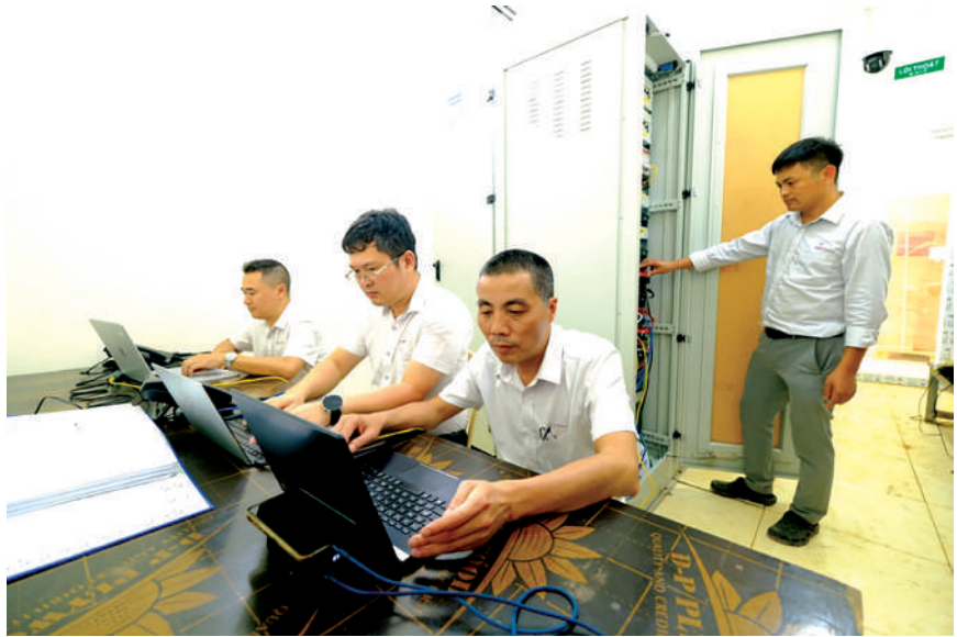
Nhân viên phòng Viễn thông và Công nghệ thông tin PTC1 bám sát công trường xây dựng TBA 500kV Thanh Hóa, thiết lập hệ thống mạng điều khiển
