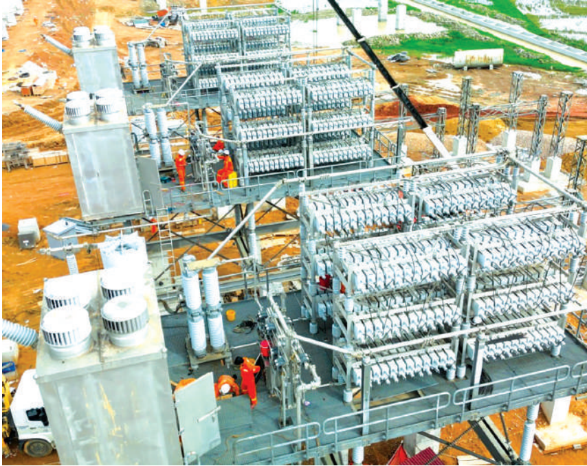
Các kỹ sư của EVNNPT tham gia lắp đặt, thí nghiệm thiết bị tại TBA 500kV Thanh Hóa
