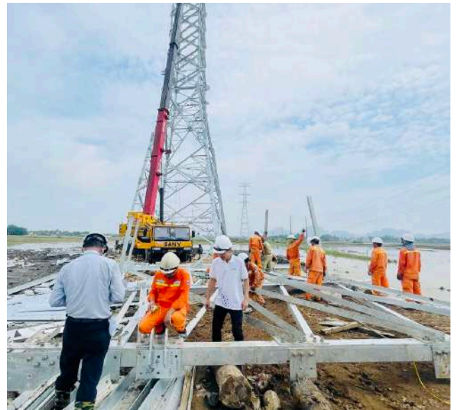
Công nhân PTC2 tham gia hỗ trợ thi công đường dây 500kV mạch 3
