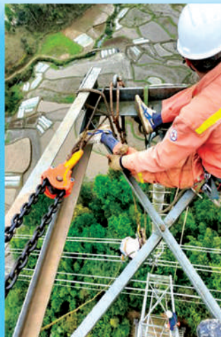
Công tác chuẩn bị
