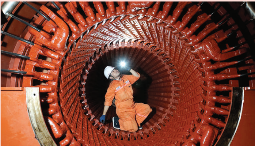
Công ty Dịch vụ sửa chữa các nhà máy điện EVNGENCO3 đã triển khai sửa chữa, bảo dưỡng RCM đạt hiệu quả tốt
