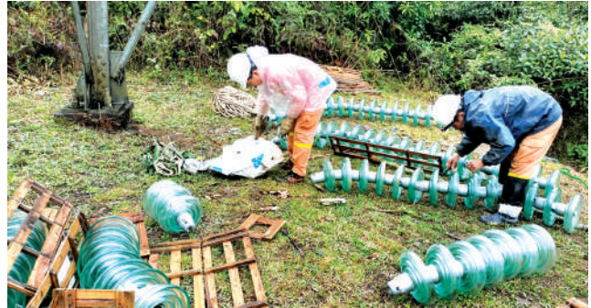
Nhóm công tác vệ sinh sứ cách điện trước khi đưa lên cột thay thế
