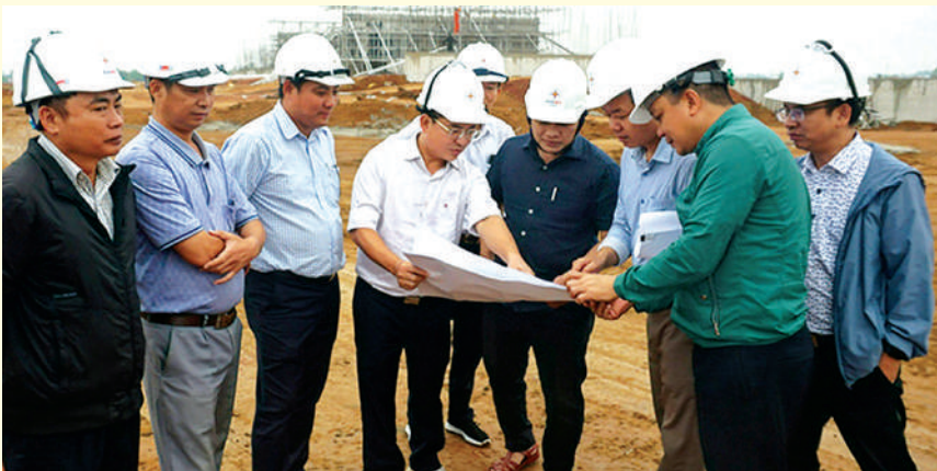
Đoàn công tác kiểm tra và nghe đại diện Phòng ĐTXD PTC1 báo cáo về tiến độ và mặt bằng thi công lắp kháng tụ tại Trạm biến áp 500kV Thanh Hóa
