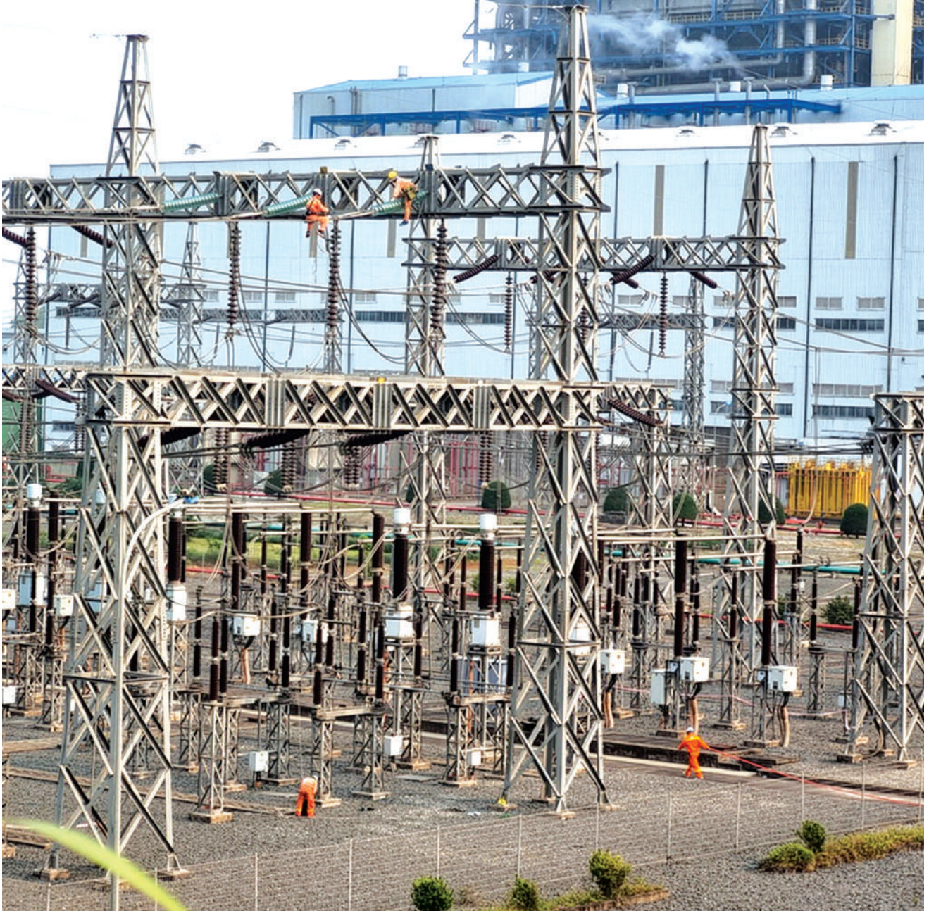
Công nhân thi công Sửa chữa, thay dây chống sét bằng dây cáp quang Đường dây 220 kV đấu nối SPP NĐ Vũng Áng 1
