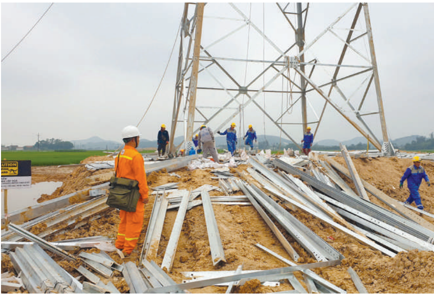
Phối hợp cùng nhà thầu, thi công kịp tiến độ thi công công trình
