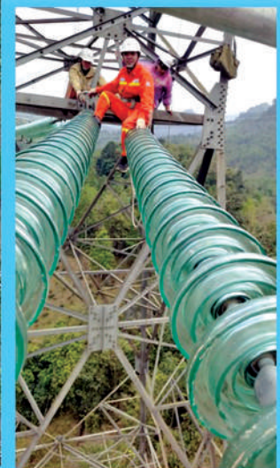
Hoàn thiện thay chuỗi sứ
