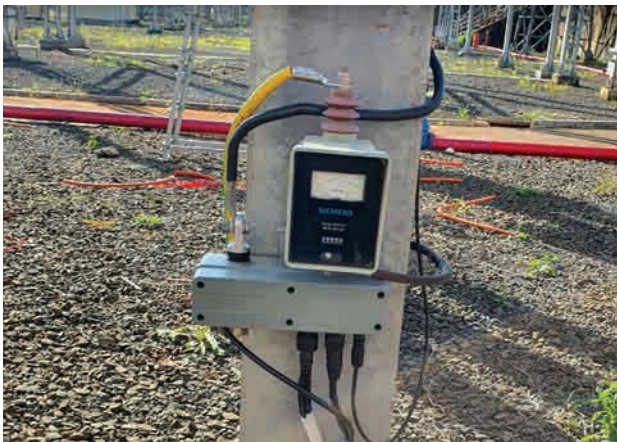
Hình 3. Lắp đặt bộ giám sát CSV ABB
