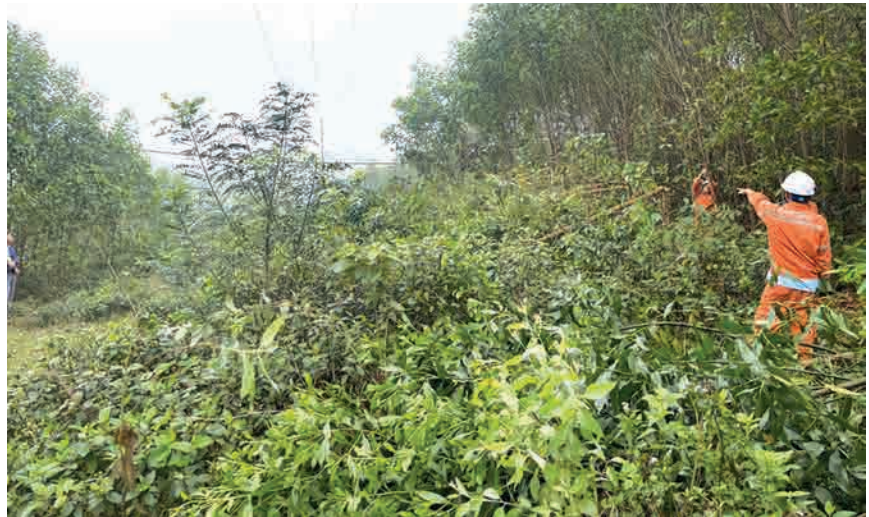
Công nhân Đội QLVLĐ cao thế Hà Tĩnh triển khai phát quang hành lang lưới điện cao áp
