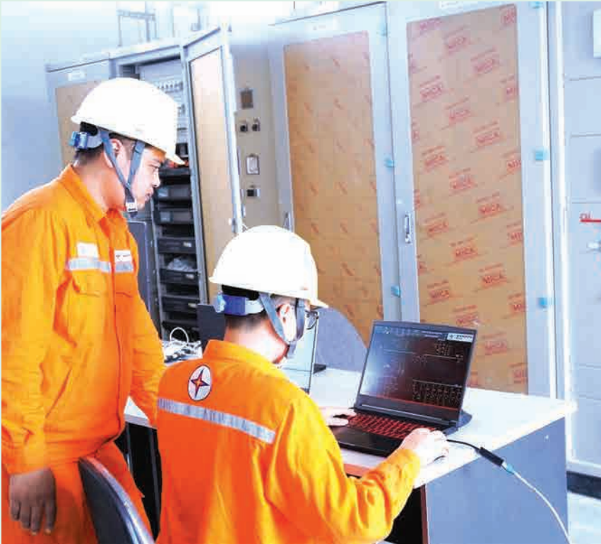
Thí nghiệm, cài đặt trước khi đưa vào vận hành TBA 110kV không người trực
