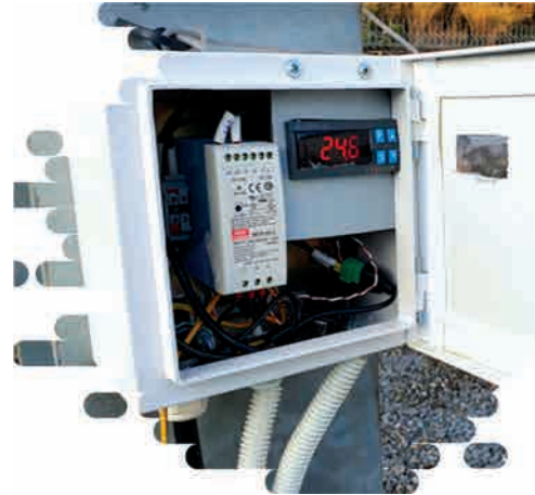
Hình 4. Lắp đặt thiết bị giám sát nhiệt độ BDA
