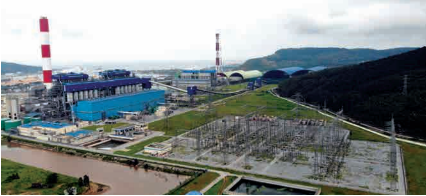
TBA 500kV Nghi Sơn có vai trò đặc biệt quan trọng giúp liên kết các đường dây 500kV Bắc-Nam, giải tỏa công suất cho 2 nhà máy Nhiệt điện Nghi Sơn 1 và Nhiệt điện Nghi Sơn 2
