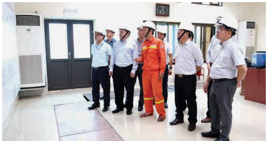
Đoàn công tác của Cục Điều tiết điện lực kiểm tra và nghe báo cáo công tác đảm bảo điện tại TBA 220kV Mai Động (Truyền tải điện Hà Nội)
