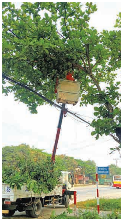
Công nhân Đội QLVLĐ cao thế Hà Tĩnh triển khai phát quang hành lang lưới điện cao áp
