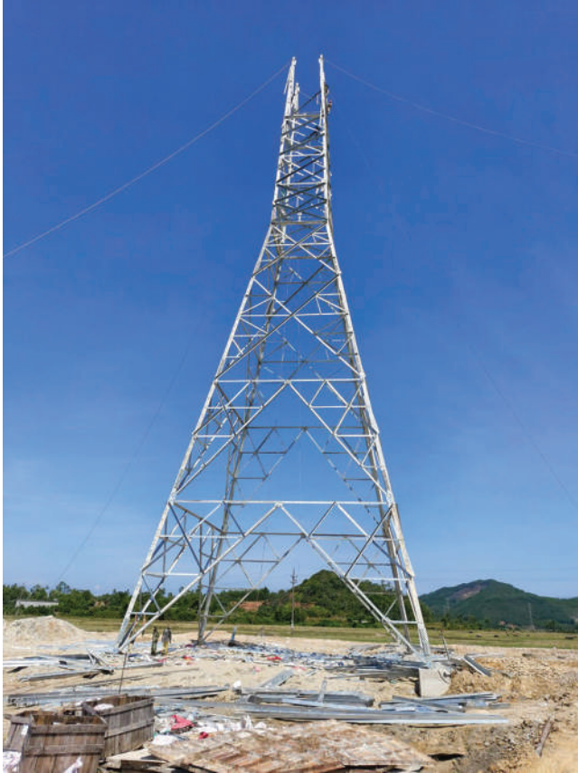
Thi công dựng cột vị trí 65 đường dây 500kV mạch 3 đoạn qua địa phận thị xã Kỳ Anh
