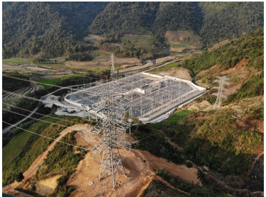
Toàn cảnh TBA 220 kV Mường Tè nhìn từ trên cao
