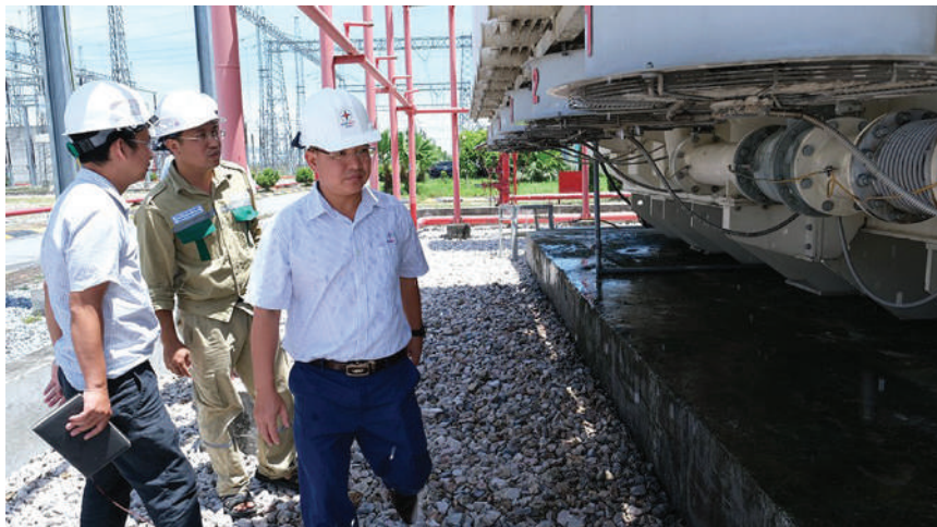
Ông Phạm Quang Hòa – Phó Giám đốc PTC1 kiểm tra công tác vận hành trạm biến áp
