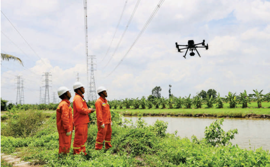
Sử dụng Flycam trong quá trình vận hành đường dây
