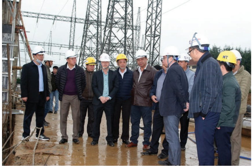
Lãnh đạo EVNNPT kiểm tra công tác thi công lắp đặt MBA 500 kV - 600 MVA tại TBA 500 kV Nho Quan
