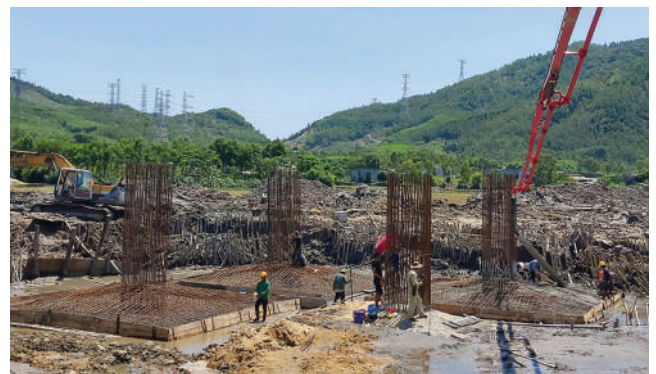
Đổ bê tông để móng vị trí 67 đường dây 500kV mạch 3 đoạn qua địa phận thị xã Kỳ Anh
