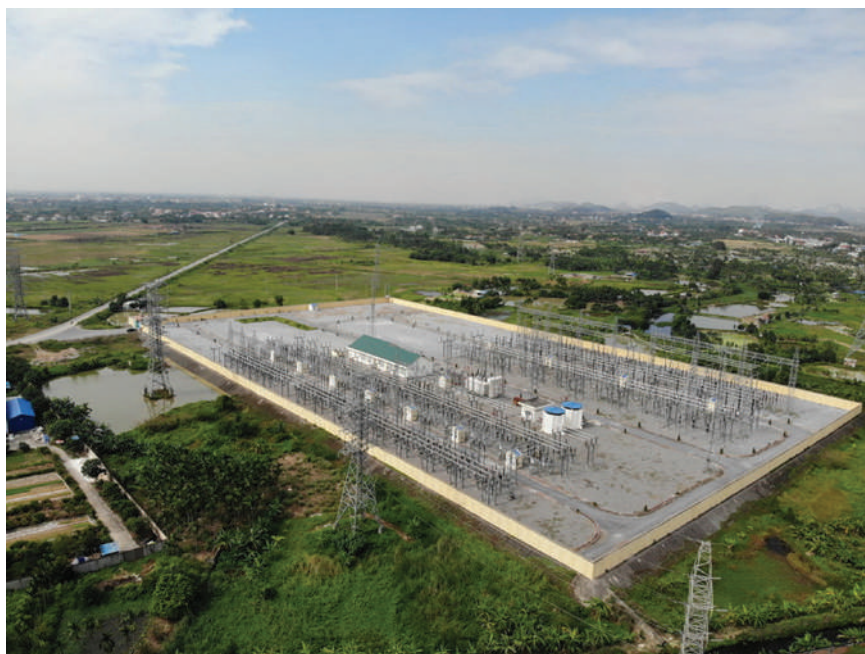
Toàn cảnh TBA số 220 kV Thủy Nguyên
